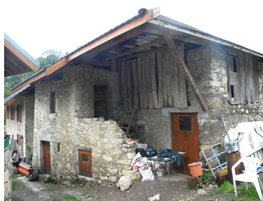
Vue du fenil au nord du bâtiment. Phot. Jérôme Daviet IVR82_20127403127NUCA
