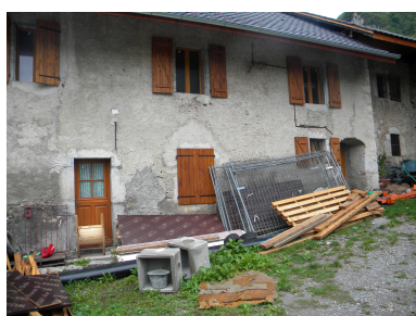
Vue du sud de la façade est. Phot. Jérôme Daviet IVR82_20127403121NUCA
