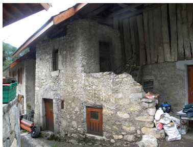
Vue de la partie sud de la façade est avec escalier extérieur. Phot. Jérôme Daviet IVR82_20127403125NUCA
