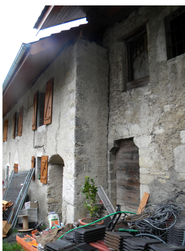
Vue de la jonction en appui entre les deux phases de construction. Phot. Jérôme Daviet IVR82_20127403122NUCA
