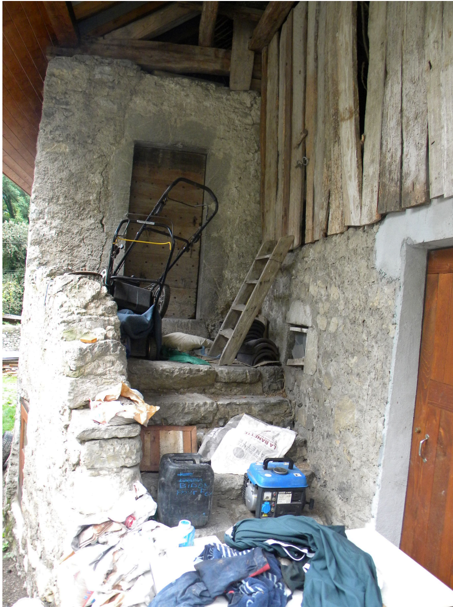
Détail de l'escalier extérieur
