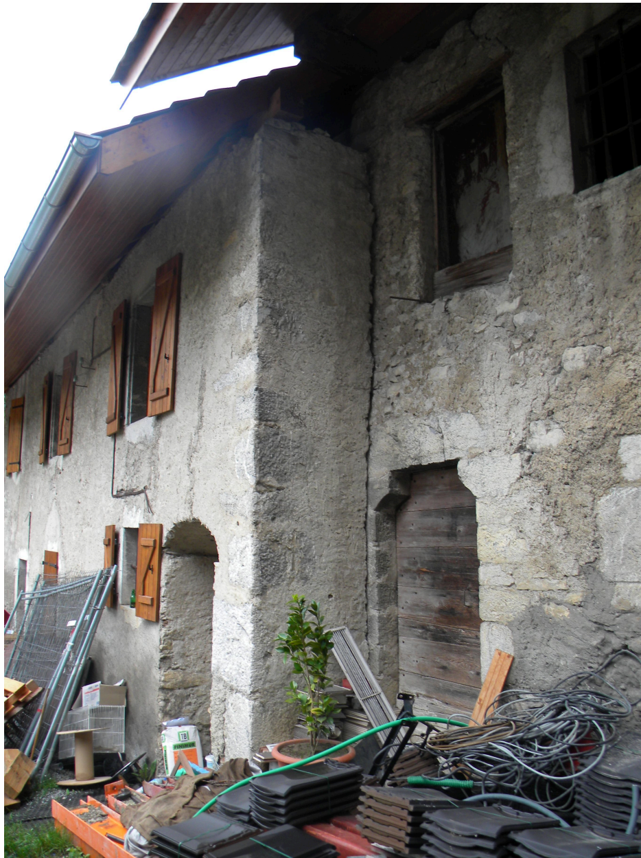
Vue de la jonction en appui entre les deux phases de construction.
