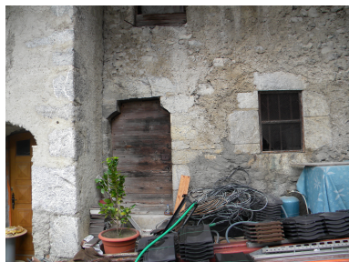
Vue d'un encadrement avec linteau sur coussinet Phot. Jérôme Daviet IVR82_20127403124NUCA
