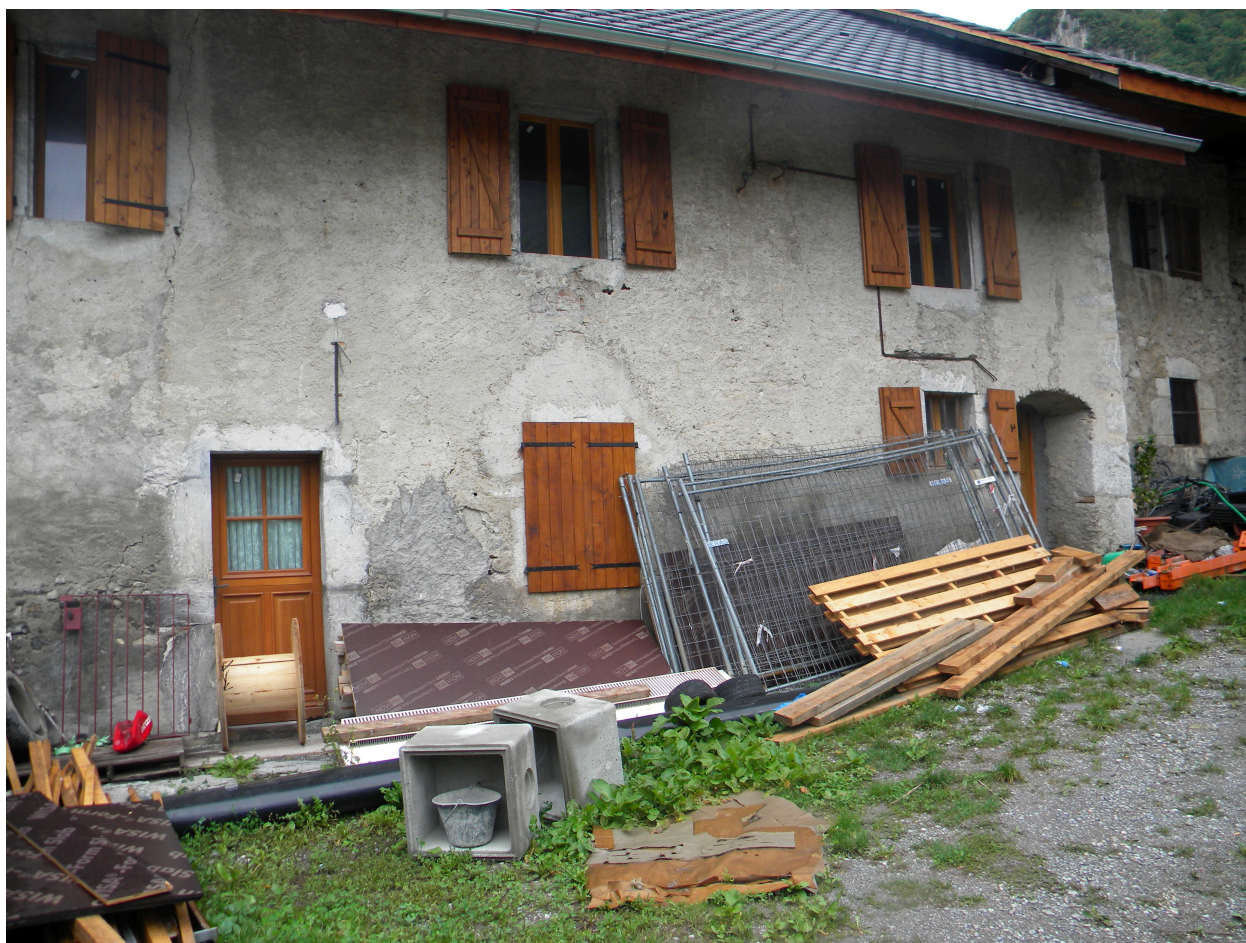
Vue du sud de la façade est.
