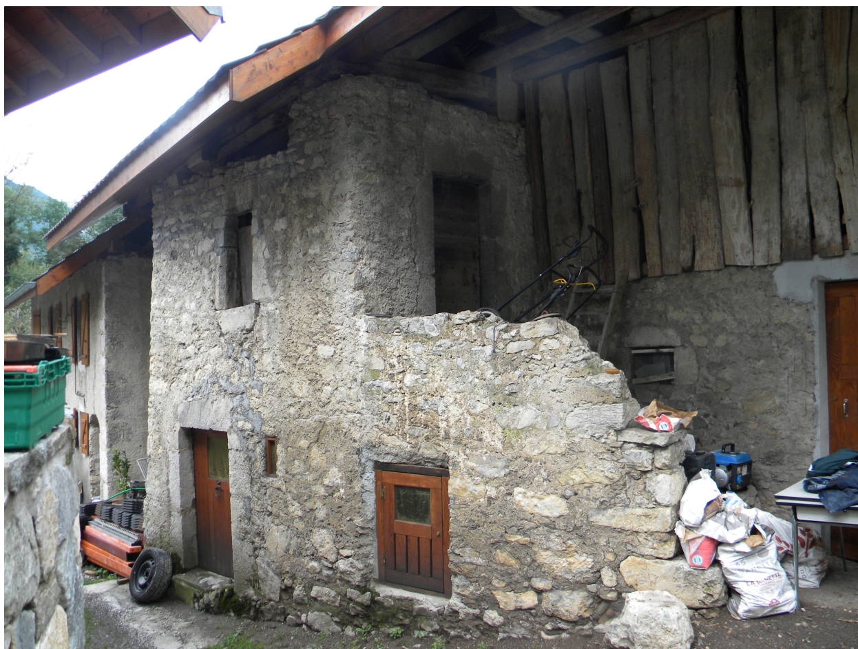
Vue de la partie sud de la façade est avec escalier extérieur.
