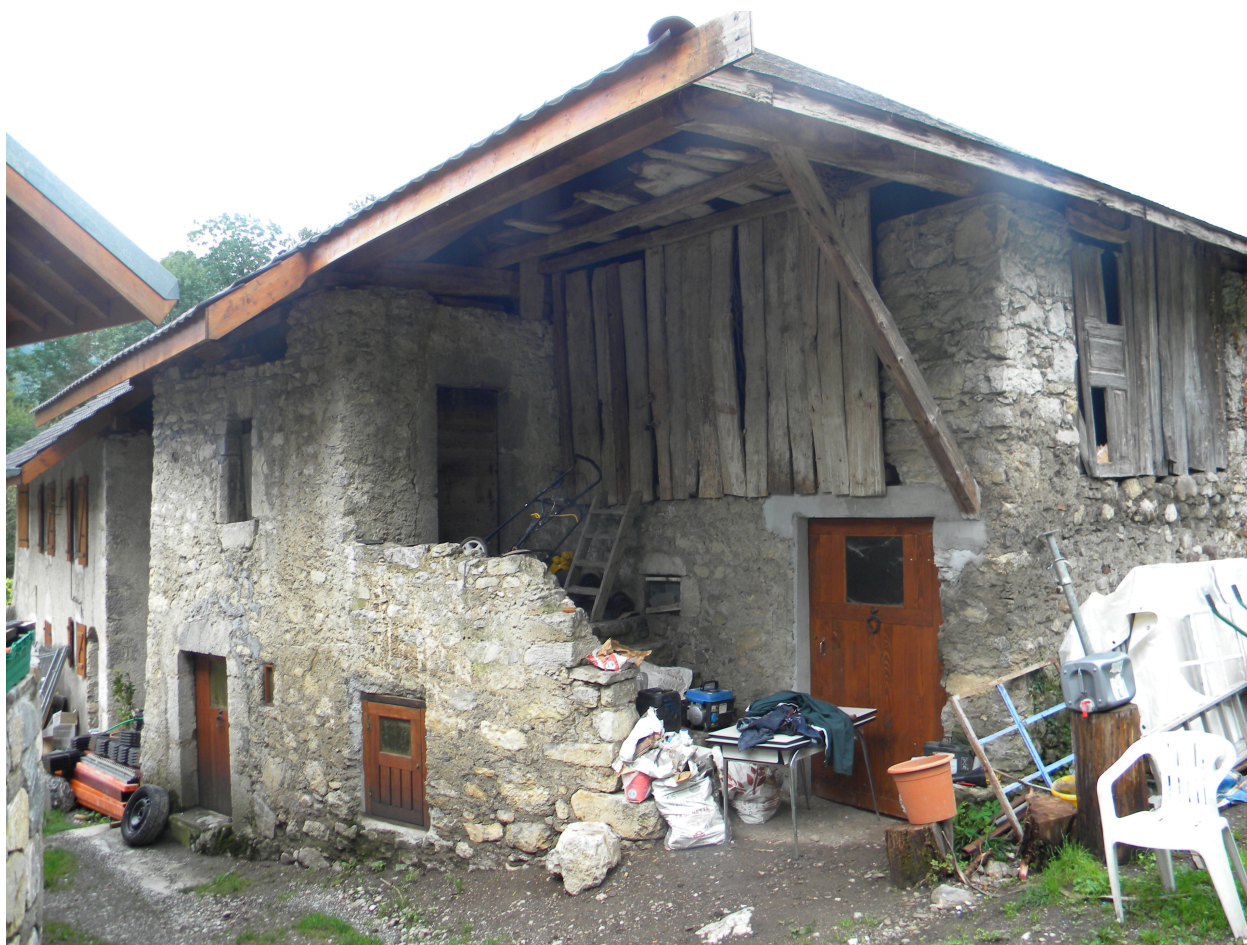
Vue du fenil au nord du bâtiment.
