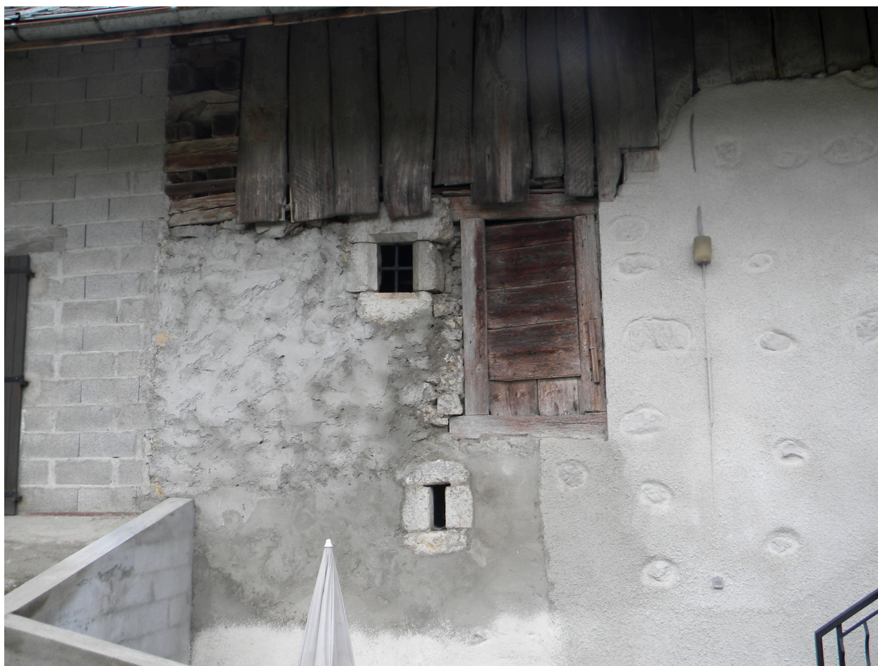
Détail d'encadrement chanfreinés en façade ouest.
