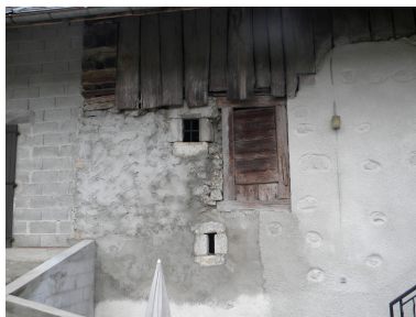
Détail d'encadrement chanfreinés en façade ouest. Phot. Jérôme Daviet IVR82_20127403119NUCA
