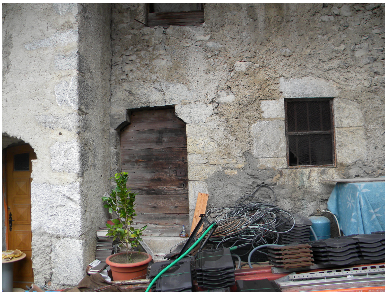
Vue d'un encadrement avec linteau sur coussinet
