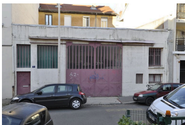
Vue générale Phot. Julien Defillon IVR82_20116902155NUCA
