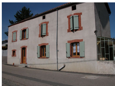
Maison à Vigne Vagye (non repérée, 1987 C 188). Phot. Thierry Monnet IVR82_20124202486NUCA
