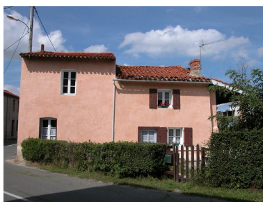
Maison au Maillet (non repérée, 1987 A 223). Phot. Thierry Monnet IVR82_20124202457NUCA
