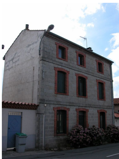
Maison au Maillet (non repérée, 1987 A 220). Phot. Thierry Monnet IVR82_20124202461NUCA
