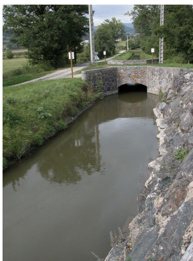
Le canal du Forez à Lot des Pierres. Phot. Caroline Guibaud IVR82_20124203014NUCA
