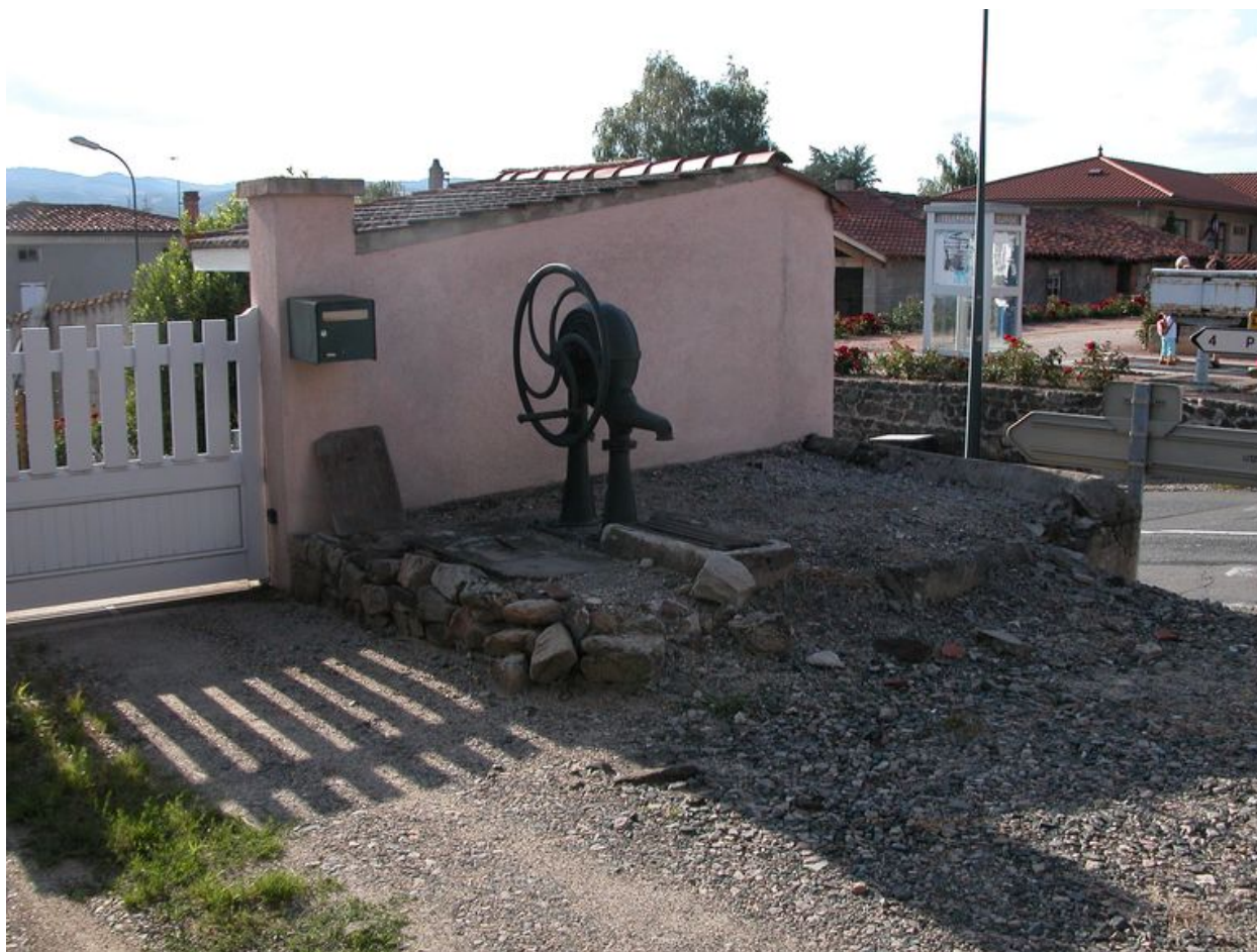
Vue de la pompe située sur un puits communal (1987 A non cadastré, vers la parcelle A 168).
