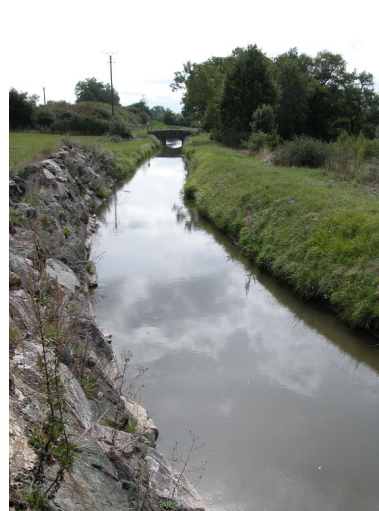
Le canal du Forez à Lot des Pierres. Phot. Caroline Guibaud IVR82_20124203015NUCA
