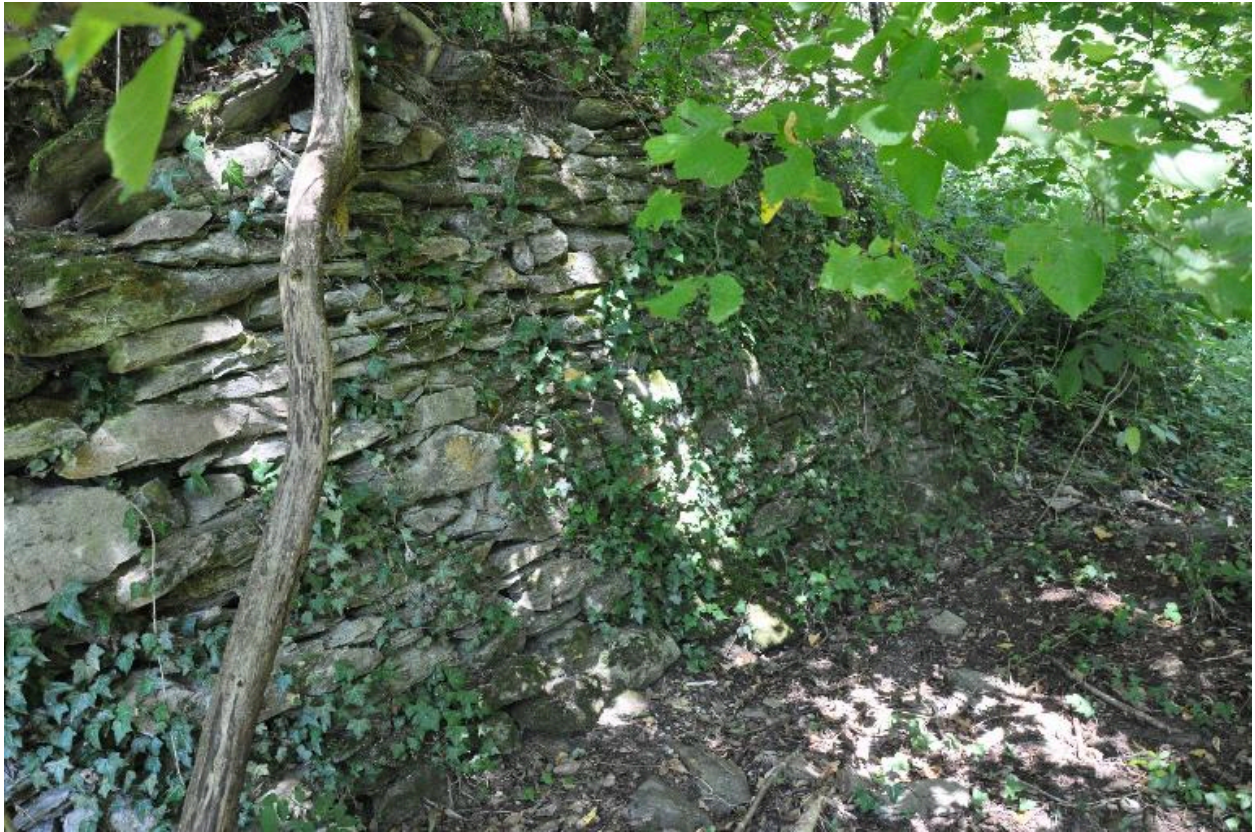
Mur sud du moulin aval.
