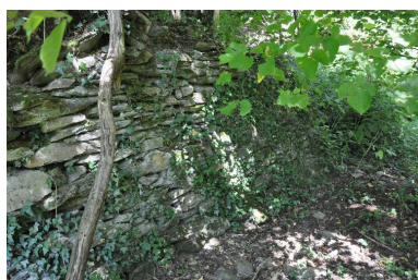
Mur sud du moulin aval. Phot. Clara Bérelle IVR84_20167302668NUCA
