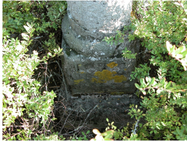
Détail du dé. Phot. Thierry Monnet IVR82_20134202776NUCA
