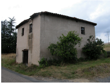
Vue générale. Phot. Thierry Monnet IVR82_20134200907NUCA
