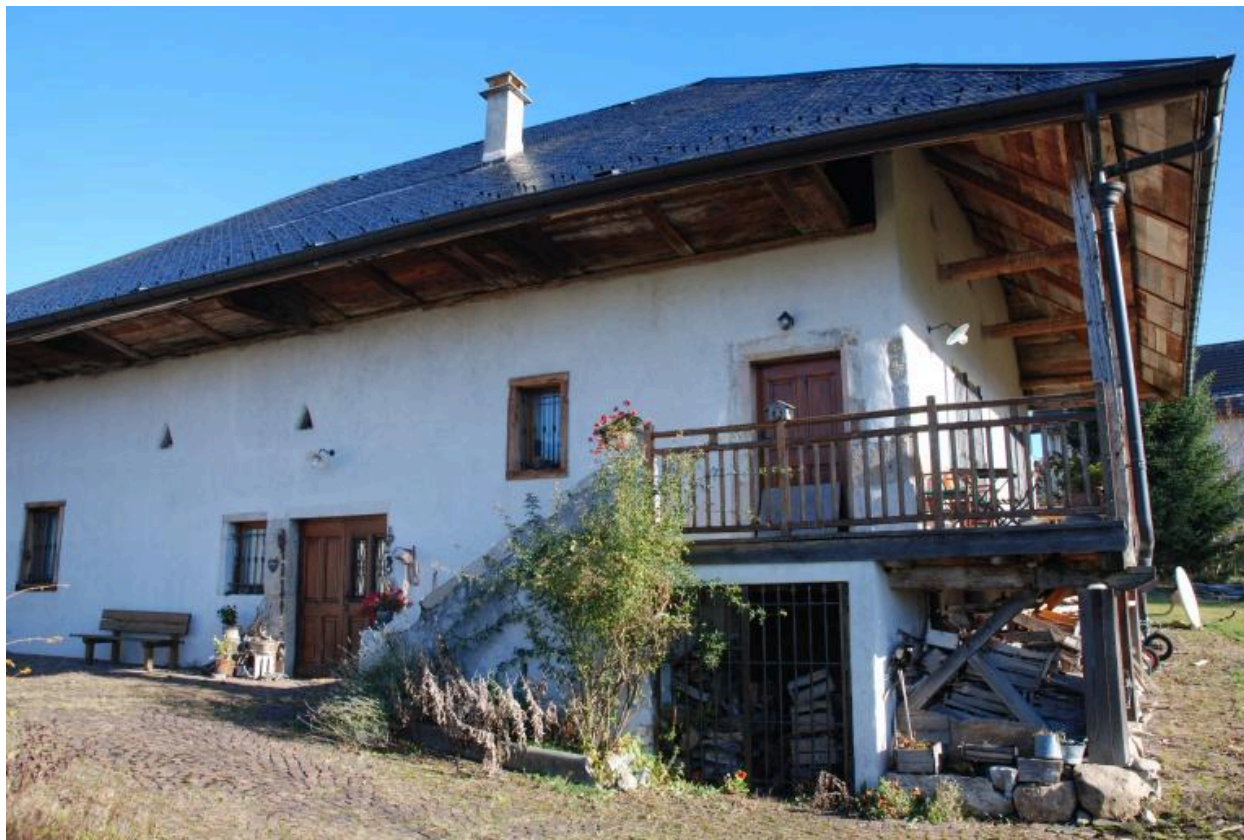
Vue d'ensemble depuis l'ouest.
