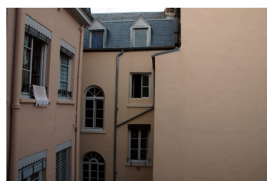
Elévation sur cour : partie supérieure Phot. Véronique Belle IVR82_20086902095NUCA
