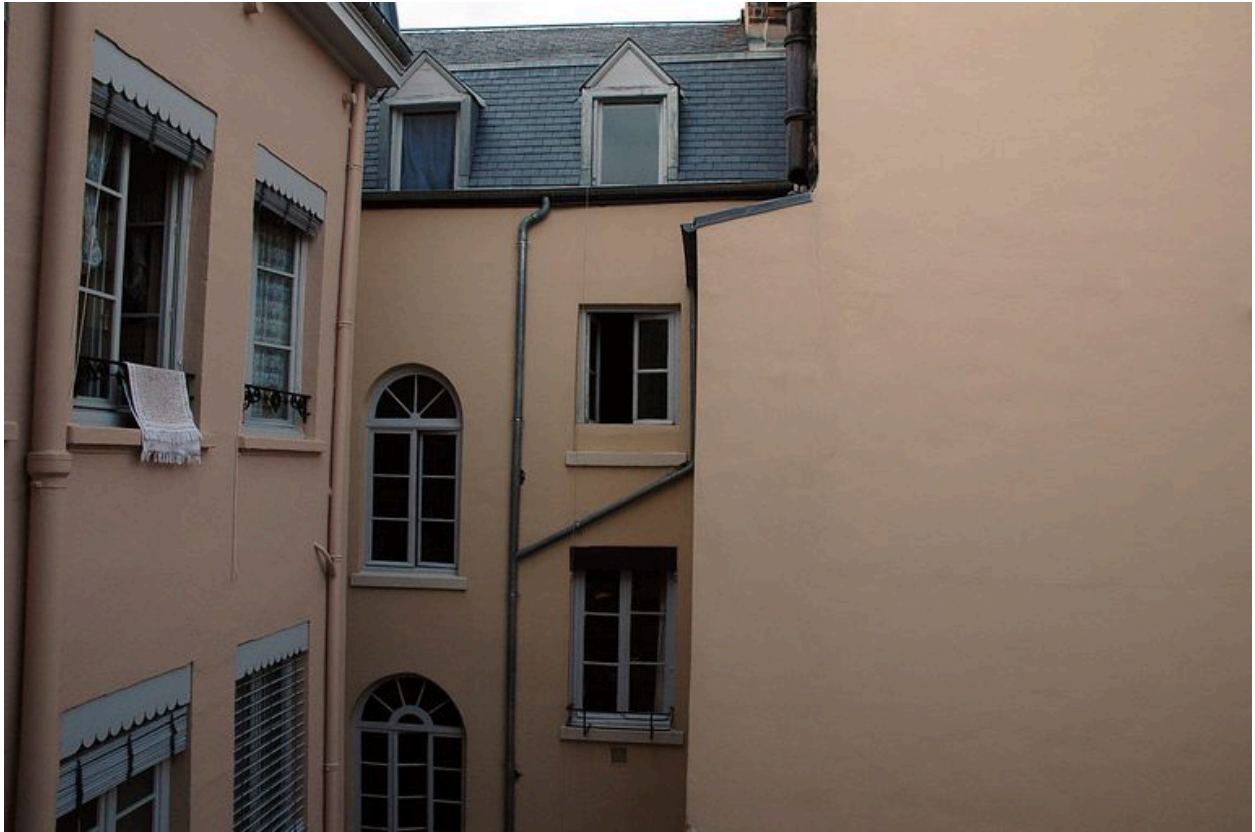
Elévation sur cour : partie supérieure
