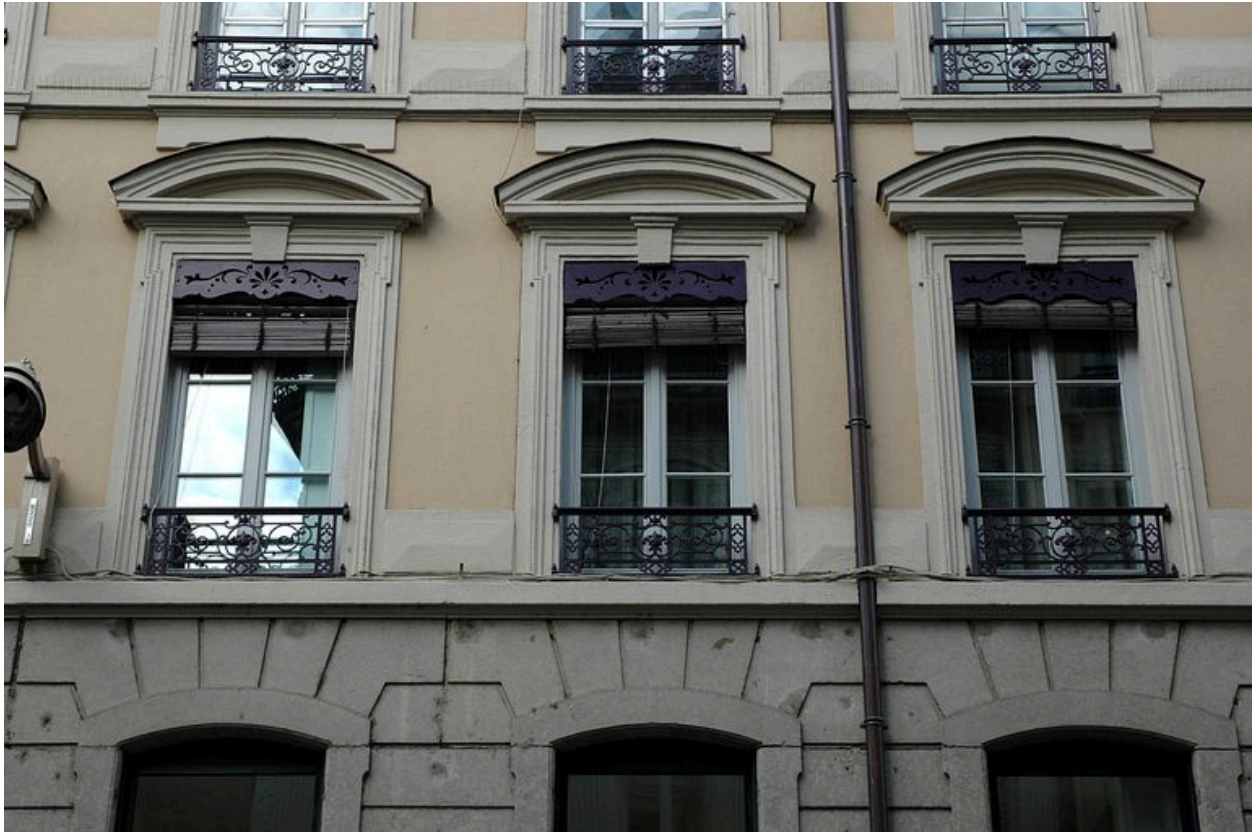
Premier étage carré : baies à fronton cintré
