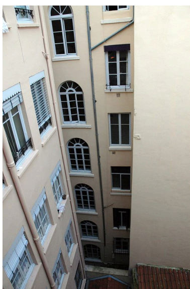
Elévation sur cour depuis la cage d'escalier de l'immeuble sis 70 rue du Président-Edouard-Herriot Phot. Véronique Belle IVR82_20086902094NUCA
