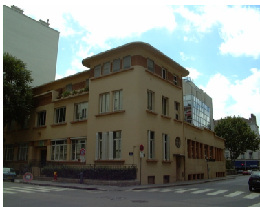
Vue nord-ouest du bâtiment Phot. Nadine Halitim-Dubois IVR82_20016903161NUCA
