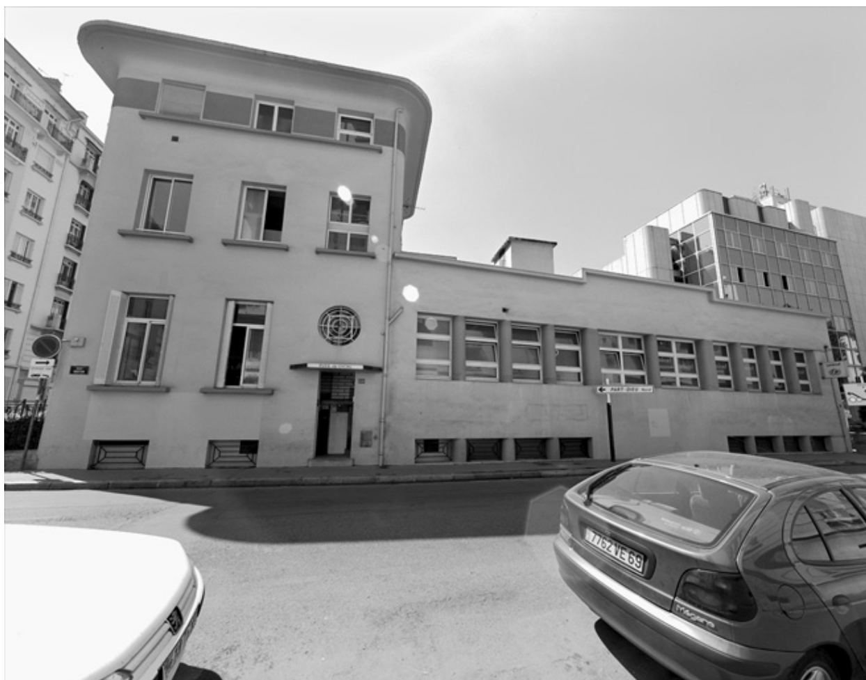
Vue façade nord
