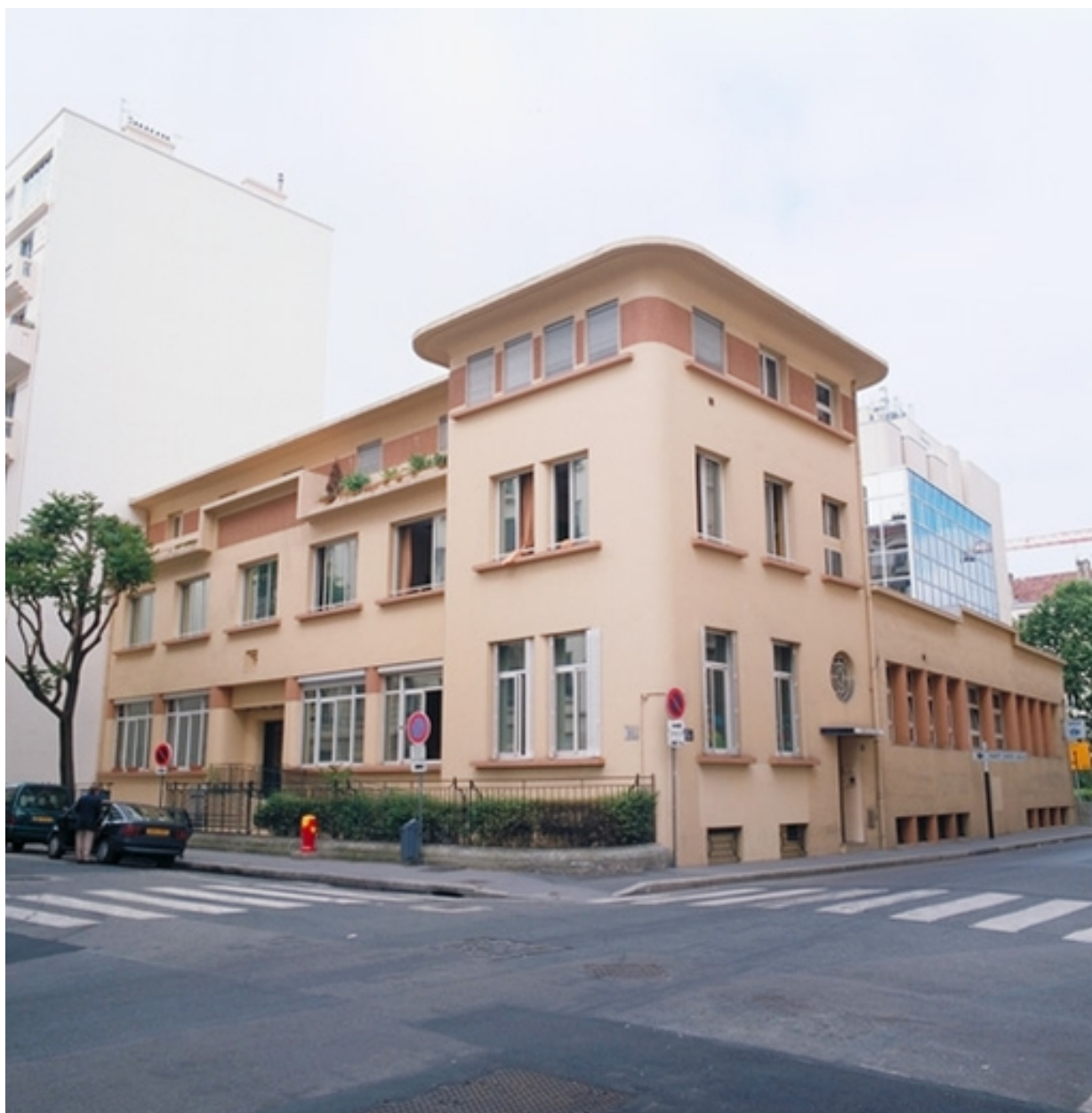
Vue d'ensemble nord-est
