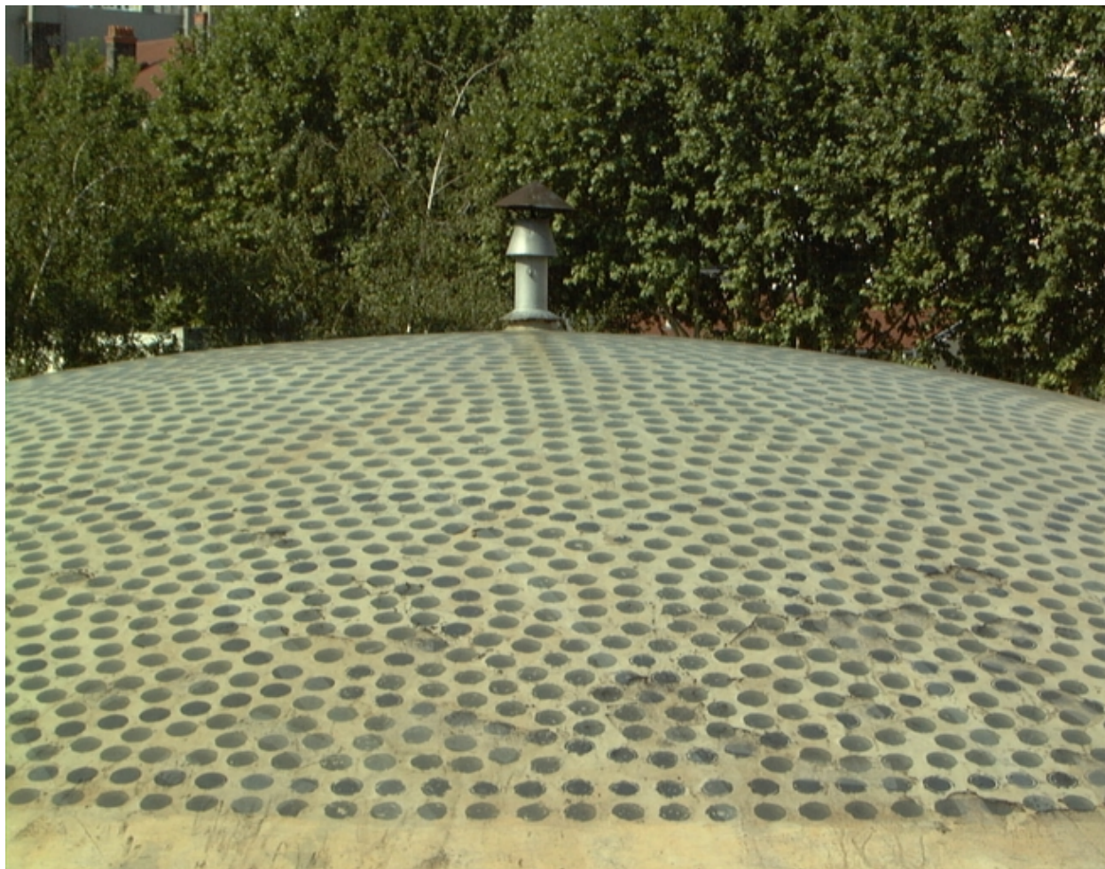
Détail de la coupole du toit
