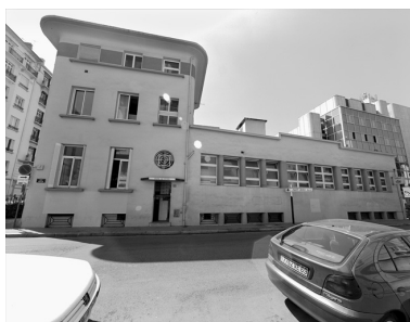
Vue façade nord Phot. Martial Couderette IVR82_20016903105V
