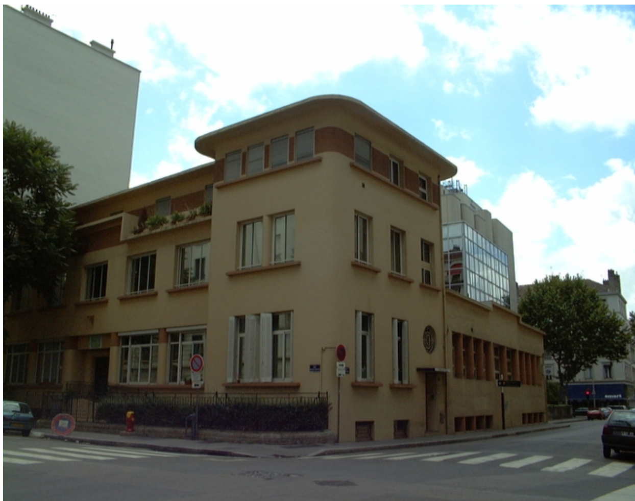
Vue nord-ouest du bâtiment
