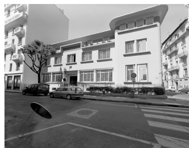
Vue est, entrée principale Phot. Martial Couderette IVR82_20016903106V
