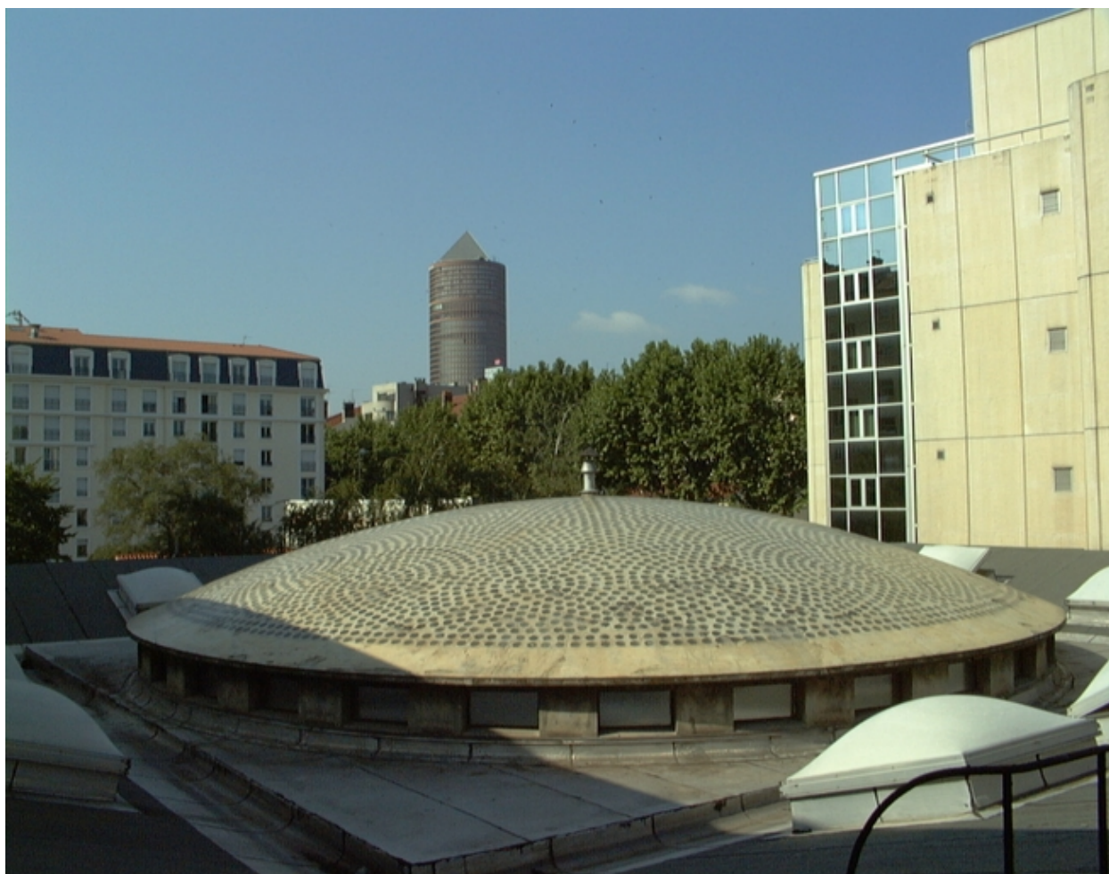
Vue de la coupole du toit
