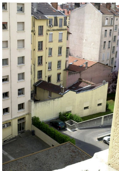
Vue d'ensemble depuis le nord-ouest : les toits du bâtiment industriel Phot. David Chevallier IVR82_20046904722NUCA
