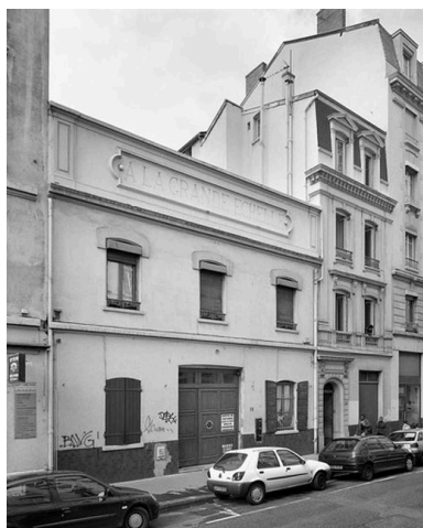
Vue générale depuis le sud-est Phot. Didier Gourbin IVR82_20066902153V
