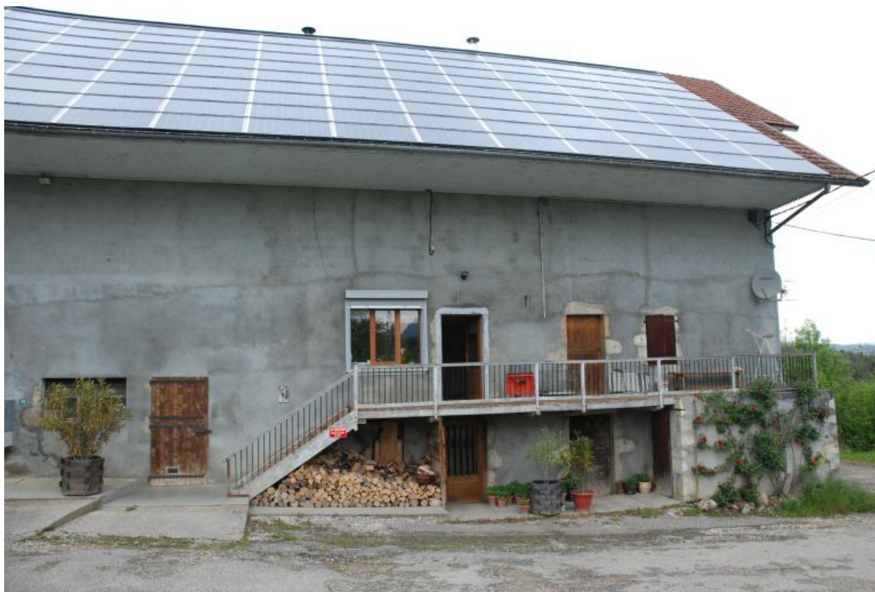
Vue de la partie habitation.
