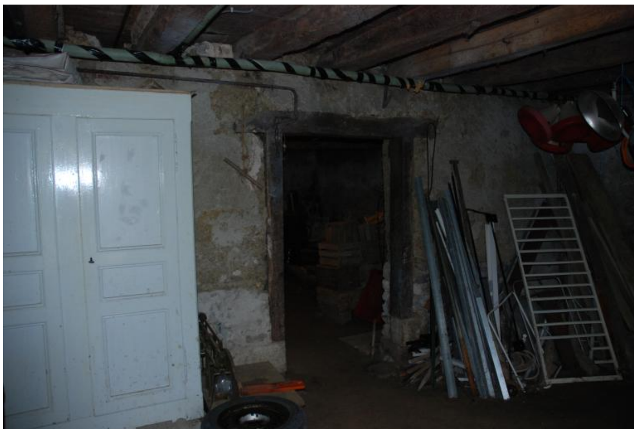
Vue intérieure : mur de refends en pisé.
