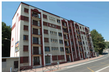
Vue générale. Phot. Catherine Guillot IVR82_20126902784NUCA
