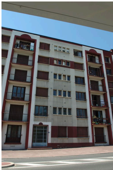
Détail de la façade sur rue. Phot. Catherine Guillot IVR82_20126902786NUCA
