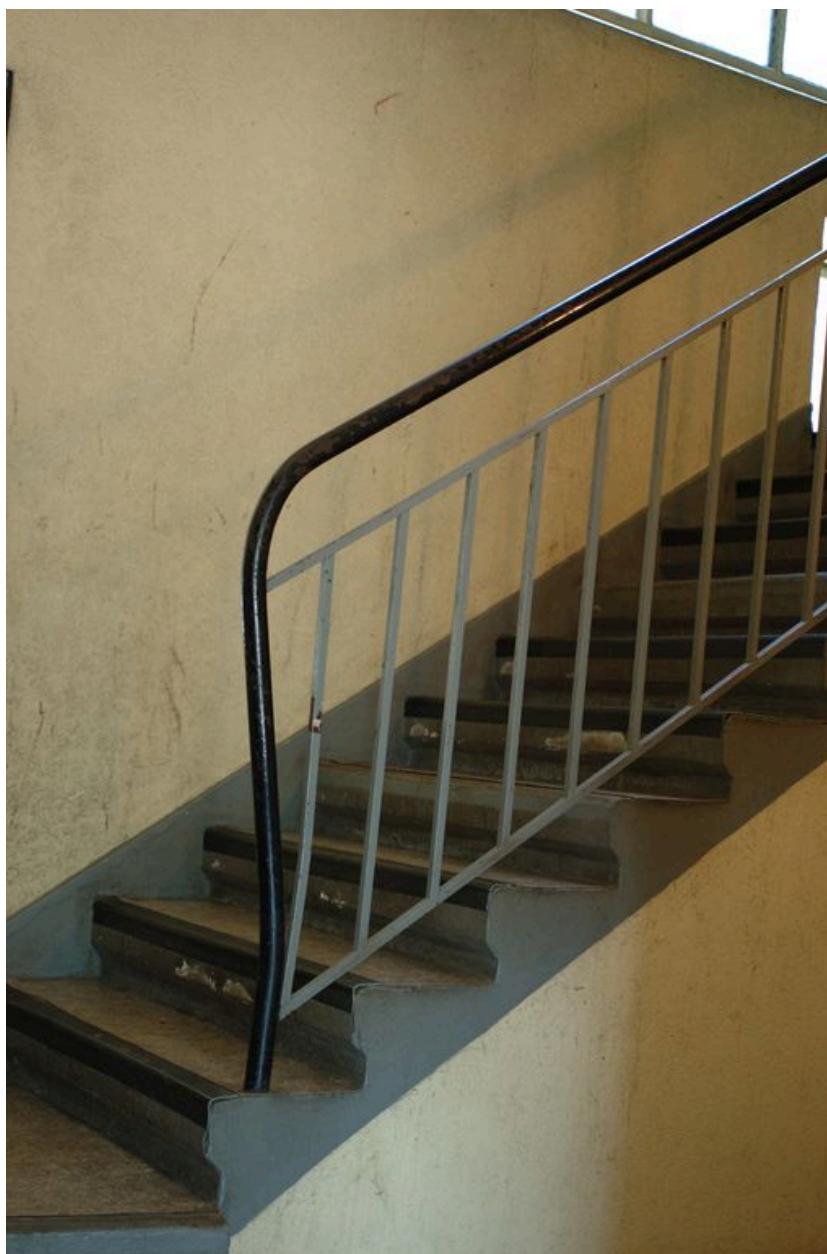
Détail de la rampe d'escalier du n°21.
