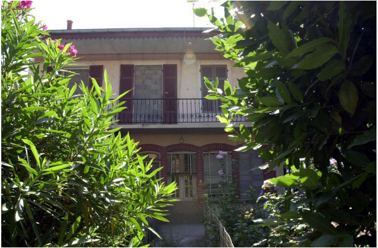
Elévation antérieure vue de face
