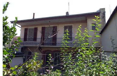
Elévation antérieure vue de biais Phot. François Blanchetière IVR82_20016902252NUCA
