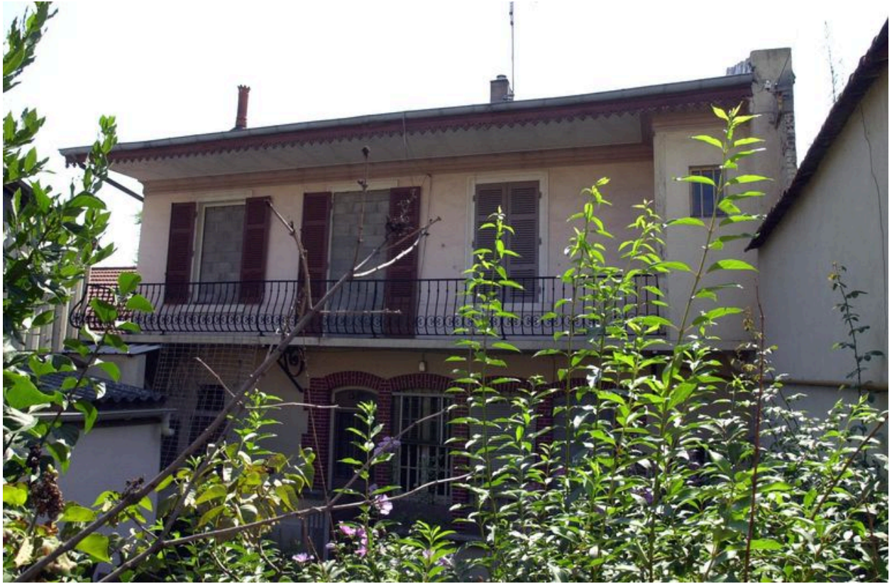
Elévation antérieure vue de biais
