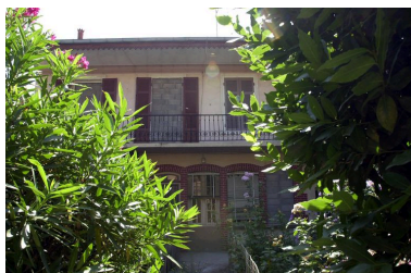
Elévation antérieure vue de face Phot. François Blanchetière IVR82_20016902251NUCA
