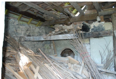
Vue partielle du four à pain. Phot. Thierry Monnet IVR84_20167302907NUCA
