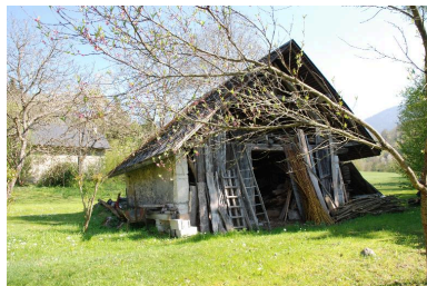
Vue d'ensemble du bâtiment abritant le four à pain et le pressoir. Phot. Thierry Monnet IVR84_20167302906NUCA
