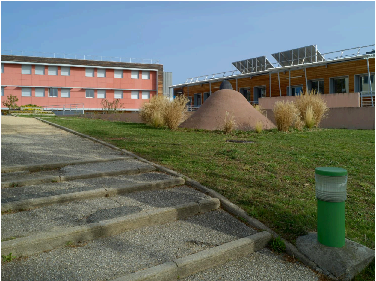
Vue générale, dans son environnement.
