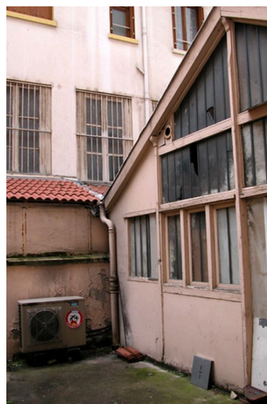
Atelier à droite de la cour : ancienne menuiserie Phot. N. Giroud IVR82_20046904184NUCA
