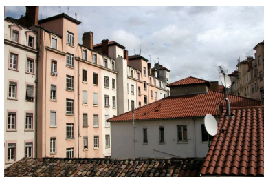
Élévation postérieure depuis un immeuble avenue Jean-Jaurès Phot. Maryannick Chalabi IVR82_20046904609NUCA
