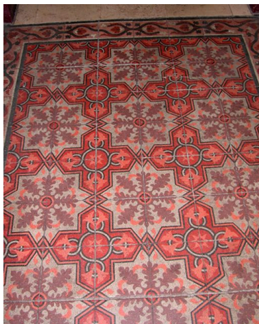
Carrelage en ciment moulé du vestibule Phot. N. Giroud IVR82_20046904182NUCA
