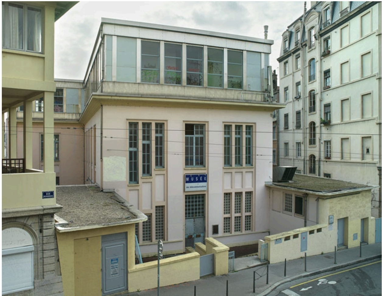
Vue d'ensemble nord-est
