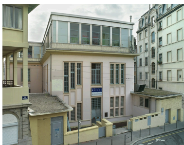
Vue d'ensemble nord-est Phot. Didier Gourbin IVR82_20106906674NUCA
