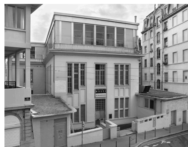
Vue générale nord-ouest Phot. Didier Gourbin IVR82_20106906675NUC
