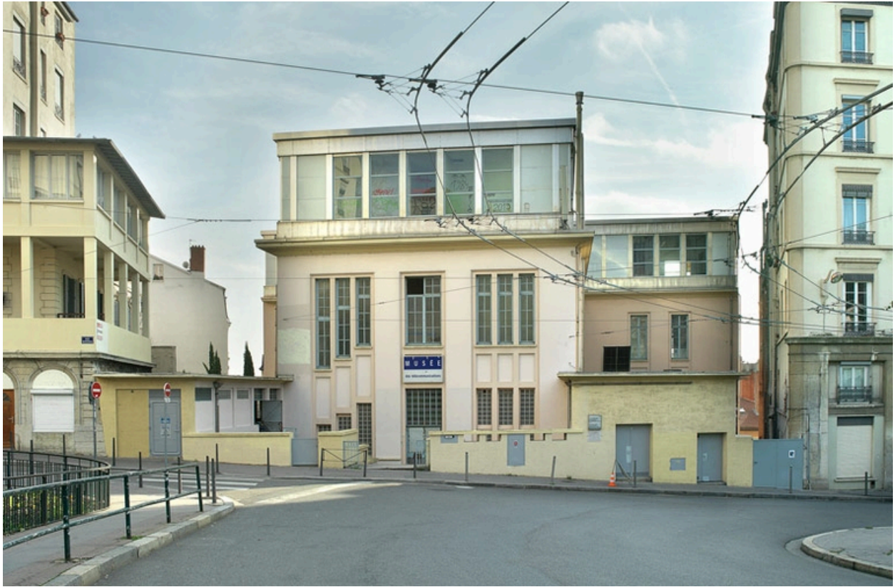
Vue générale nord
