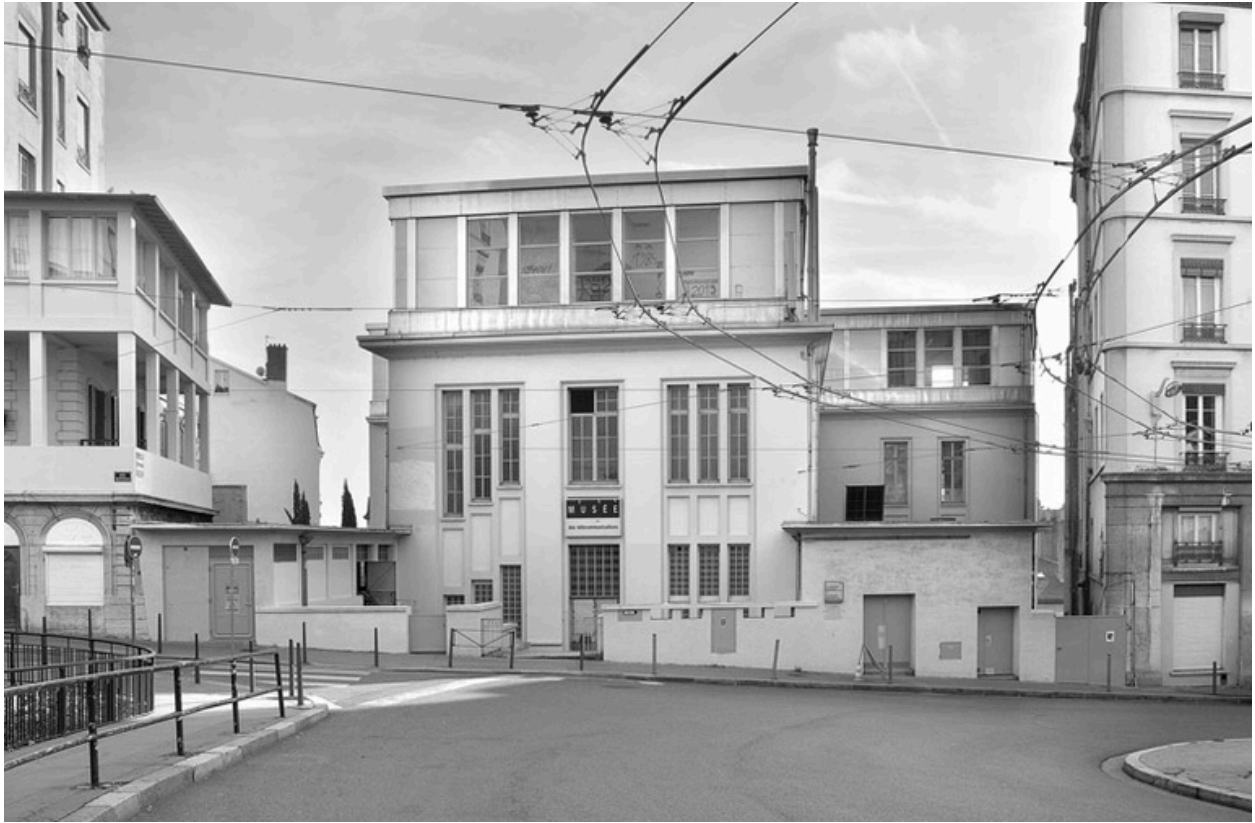
Vue d'ensemble nord (n et b)
