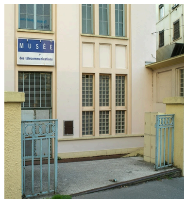
Entrée principale nord avec portail en ferronnerie Phot. Didier Gourbin IVR82_20106906663NUCA
