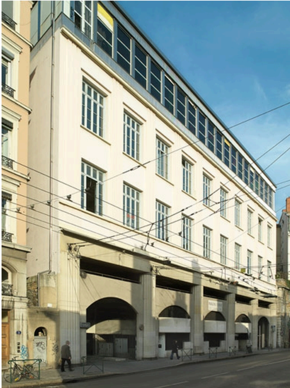
Vue d'ensemble façade sud-ouest (rue Terme)
