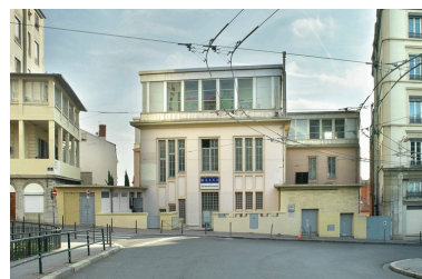
Vue générale nord Phot. Didier Gourbin IVR82_20106906660NUCA
