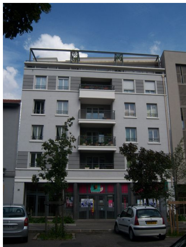
Elevation du premier corps sur rue Marcel Mérieux Phot. Salohy Rakotomalala IVR82_20106901461NUCA
