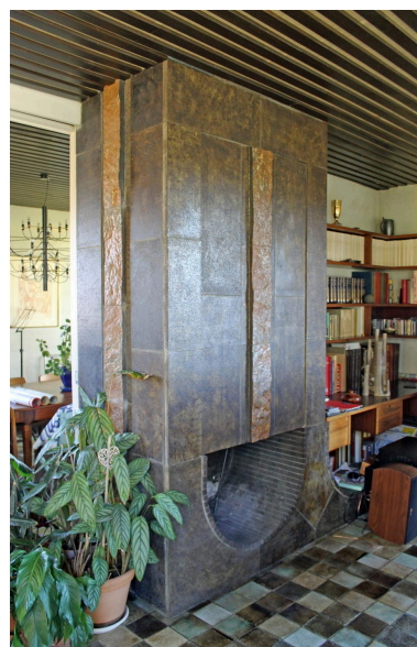
Ceyrat, la maison L., la cheminée du séjour revêtue de plaques de lave émaillée et de briquettes. Le plafond est revêtu de lattes de bois et de tissu. Phot. Christophe Laurent IVR84_20216302580NUCA
