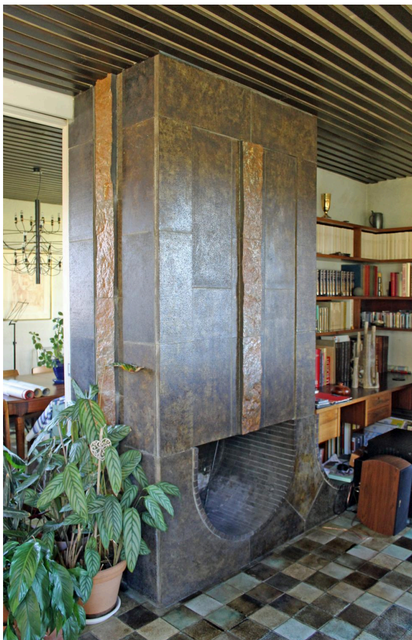
Ceyrat, la maison L., la cheminée du séjour revêtue de plaques de lave émaillée et de briquettes. Le plafond est revêtu de lattes de bois et de tissu.
