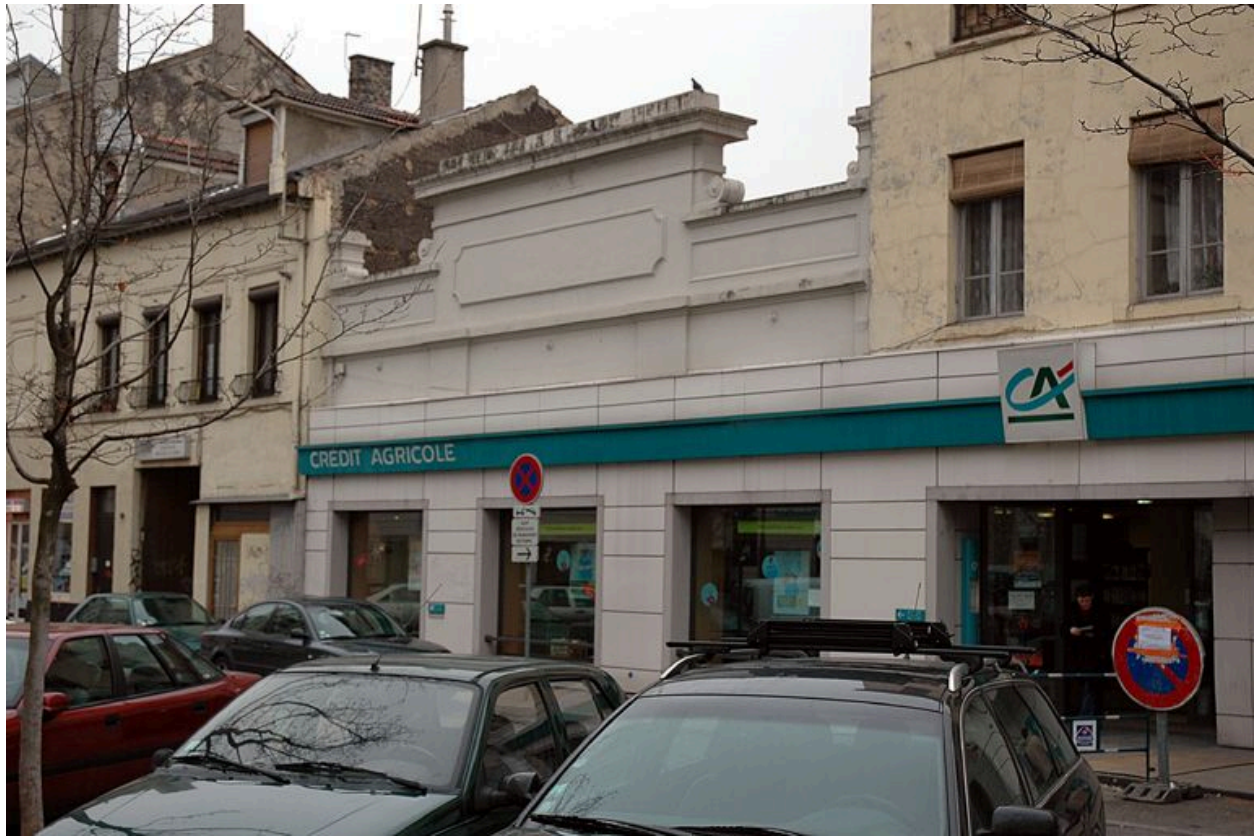
Vue générale du bâtiment sur rue
