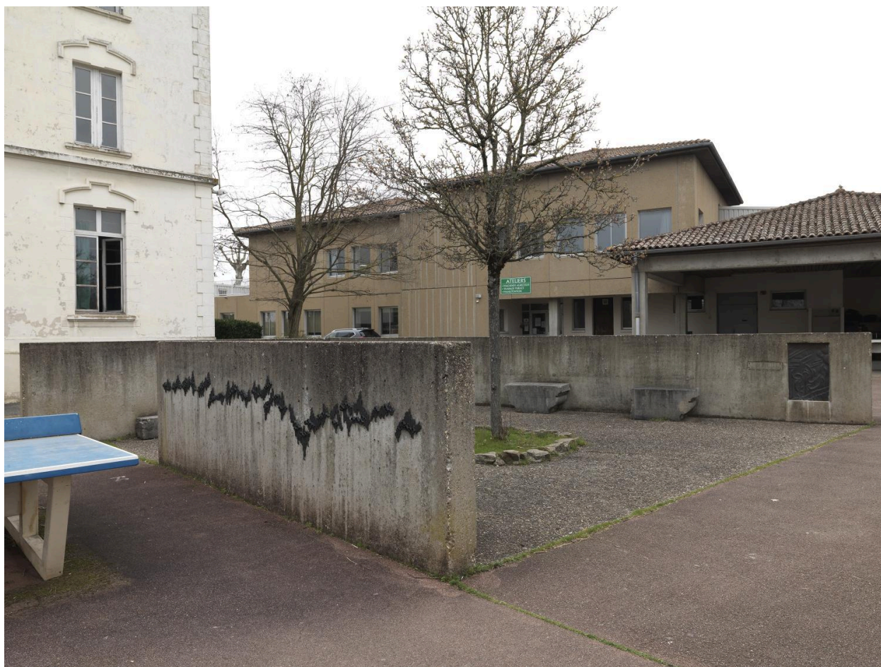
Vue d'ensemble de l'installation.
