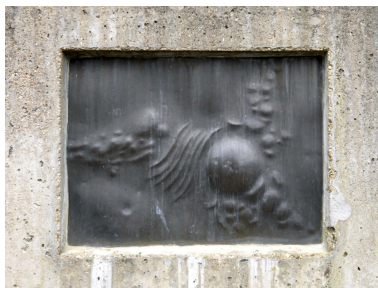
Un des panneaux en laiton. Phot. Franck Trabouillet IVR84_20210100287NUCA
