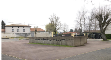
Motif horizontal sur le mur extérieur de l'installation. Phot. Franck Trabouillet IVR84_20210100290NUCAQ
