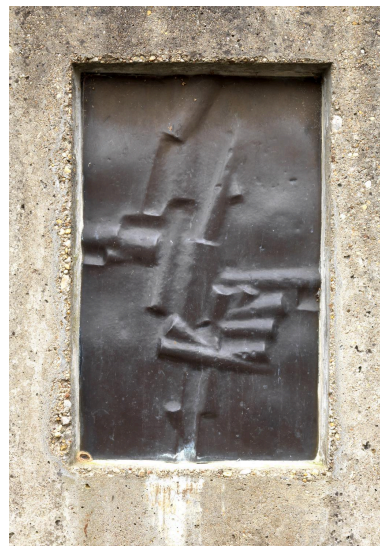
Un des panneaux en laiton. Phot. Franck Trabouillet IVR84_20210100288NUCA
