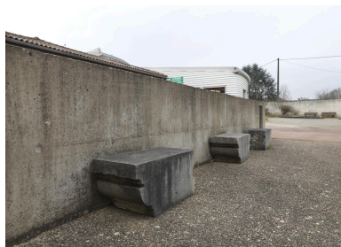
Vue d'ensemble des sièges. Phot. Franck Trabouillet IVR84_20210100285NUCA
