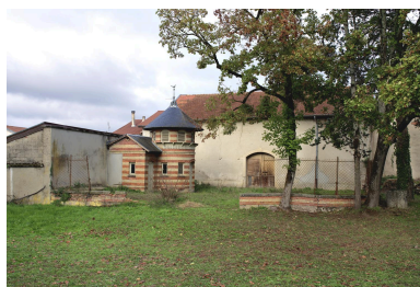
Vue d'ensemble de la basse-cour, avec sa clôture Phot. Franck Trabouillet IVR84_20200101097NUCAQ
