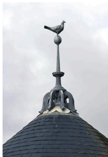
Détail de toiture et épi de faitage Phot. Franck Trabouillet IVR84_20200101101NUCA
