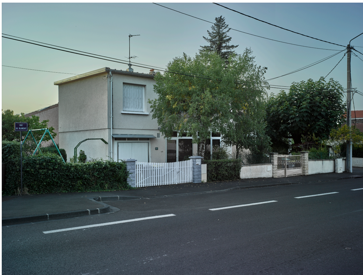
Habitation double (années 1958-1959) : élévation principale sur la rue de Blanzat.
