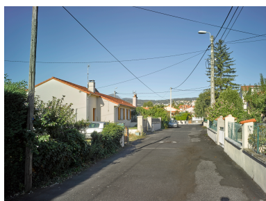
Anciennes habitations Michelin de l'impasse (côté est) ouvrant sur la rue de Blanzat (années 1952-1953). Phot. Christian Parisey IVR84_20196300260NUC4A
