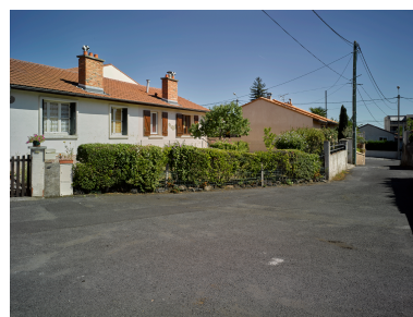
Anciennes habitations Michelin de l'impasse (ouest) ouvrant sur la rue de Blanzat (années 1952-1953) : au premier plan, un ensemble de maisons jumelées. Phot. Christian Parisey IVR84_20196300263NUC4A
