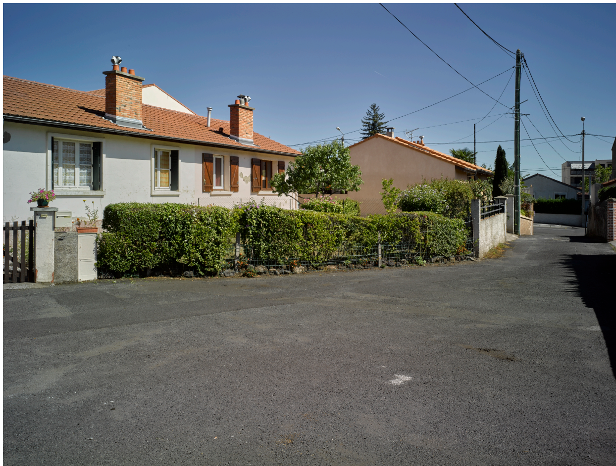
Anciennes habitations Michelin de l'impasse (ouest) ouvrant sur la rue de Blanzat (années 1952-1953) : au premier plan, un ensemble de maisons jumelées.
