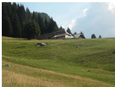
Vue d'ensemble. Phot. Jérôme Daviet IVR84_20167304251NUCA
