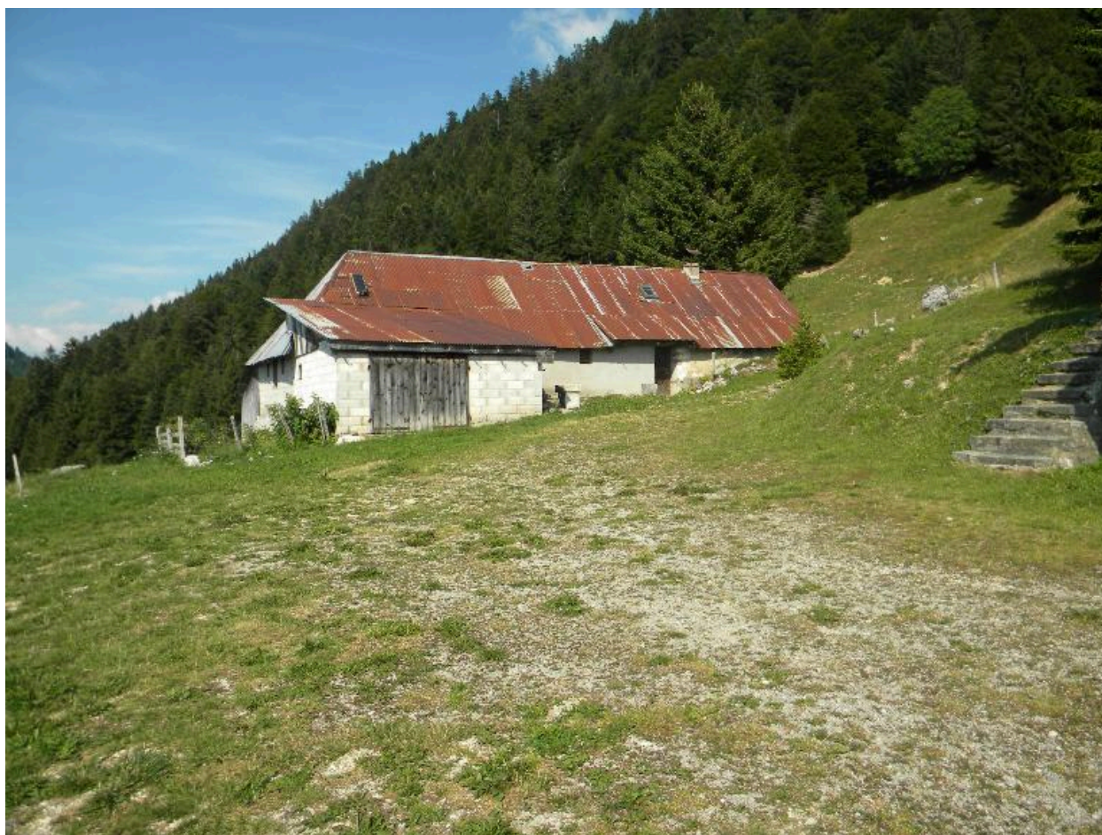
Vue de la façade sud.
