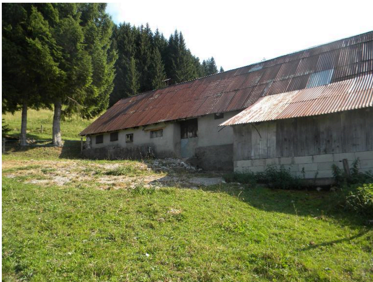
Vue de la façade nord.
