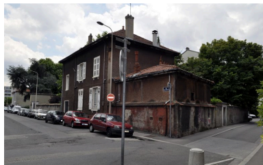
Vue d'ensemble Phot. Catherine Guégan IVR82_20096904312NUCA
