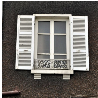
Détail de la façade rue Saint-Hippolyte : fenêtre Phot. Catherine Guégan IVR82_20096904314NUCA
