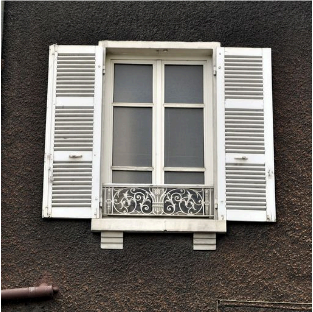
Détail de la façade rue Saint-Hippolyte : fenêtre
