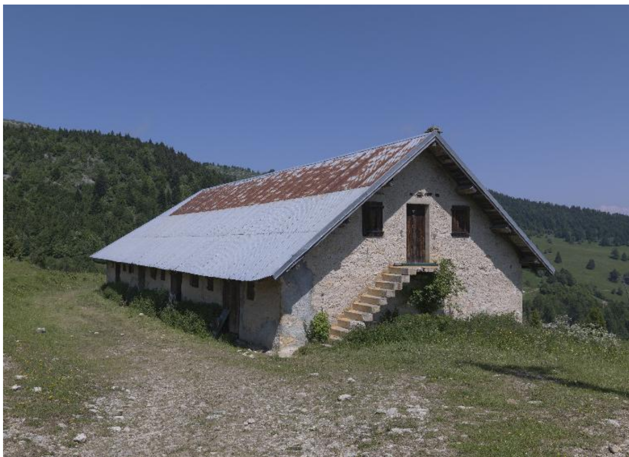
Vue d'ensemble de l'étable nord.
