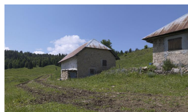
Vue du bâtiment médian, depuis le nord-est. Phot. Eric Dessert IVR82_20147304433NUCA
