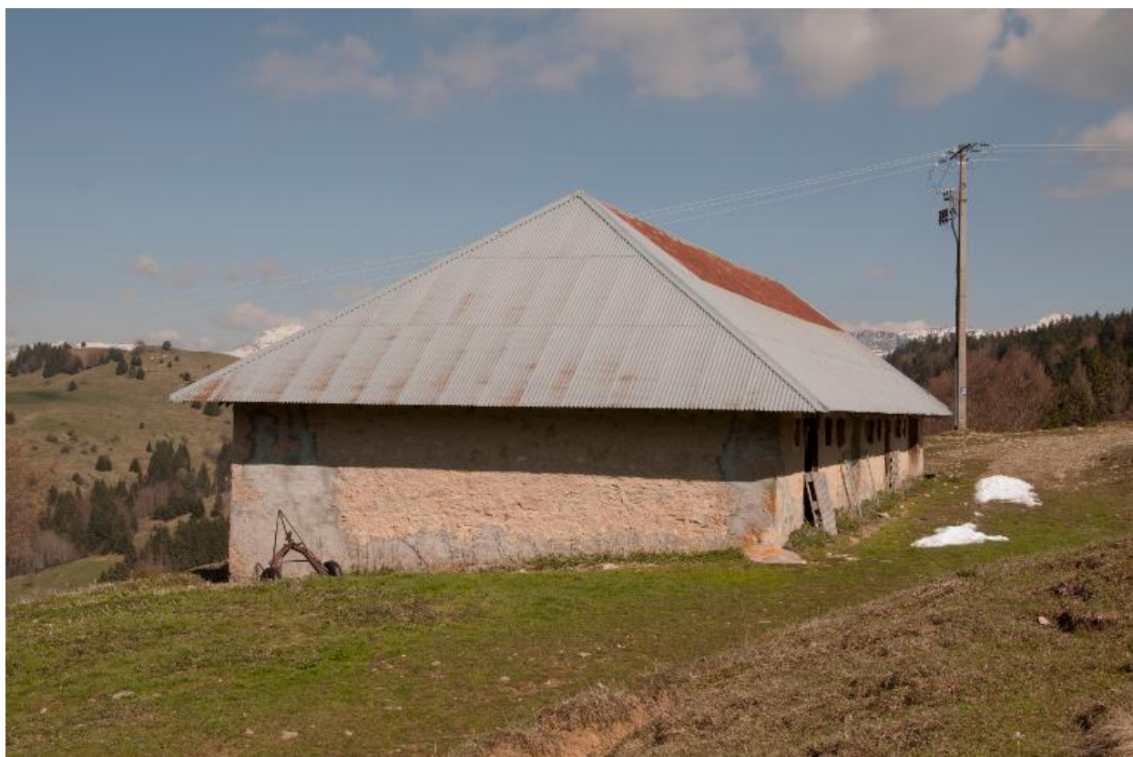
Vue de l'étable nord, depuis le sud-ouest.
