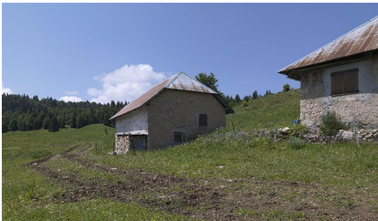
Vue du bâtiment médian, depuis le nord-est.
