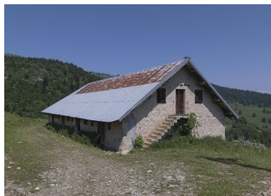
Vue d'ensemble de l'étable nord. Phot. Eric Dessert IVR82_20147304431NUCA
