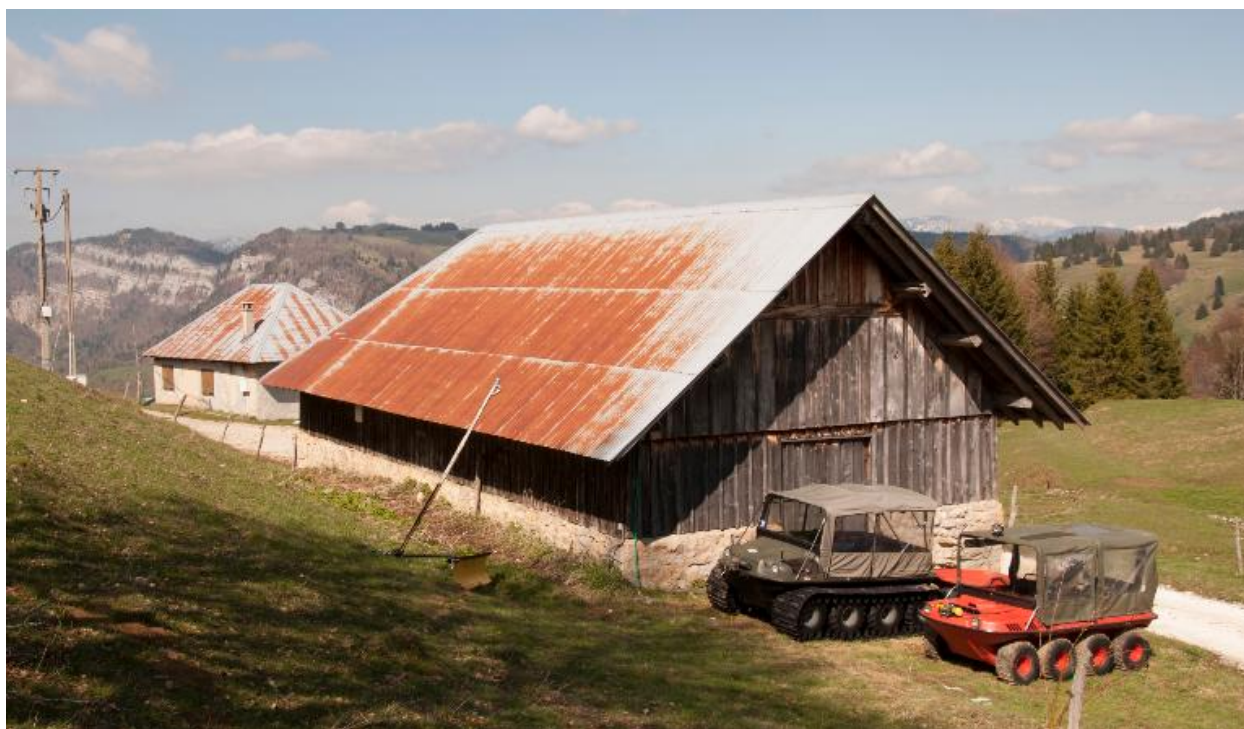
Vue de l'étable sud, depuis le sud-ouest.
