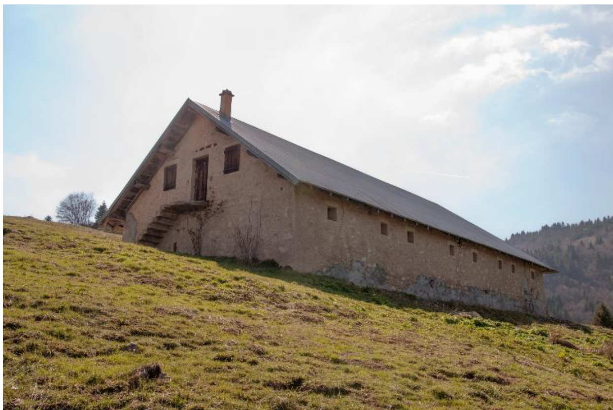
Vue de l'étable nord, depuis le nord-est.
