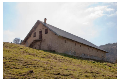
Vue de l'étable nord, depuis le nord-est. Phot. Denys Harreau IVR84_20167304774NUCA
