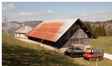
Vue de l'étable sud, depuis le sud-ouest. Phot. Denys Harreau IVR84_20167304764NUCA
