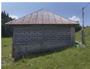
Vue du bâtiment nord, face nord : madriers ajourés pour l'aération du freidi. Phot. Eric Dessert IVR82_20147304434NUCA
