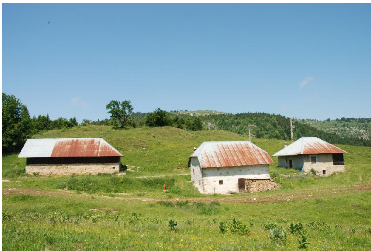
Vue générale depuis l'est.
