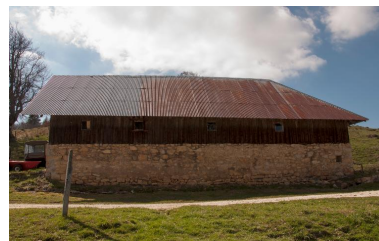
Vue de l'étable sud, façade est. Phot. Denys Harreau IVR84_20167304766NUCA
