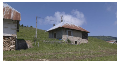
Vue du bâtiment nord, depuis le sud-est. Phot. Eric Dessert IVR82_20147304432NUCA
