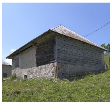
Vue du bâtiment nord, depuis le nord-est. Phot. Eric Dessert IVR82_20147304435NUCA
