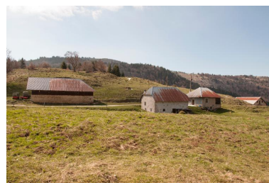
Vue générale depuis l'est. Phot. Denys Harreau IVR84_20167304768NUCA
