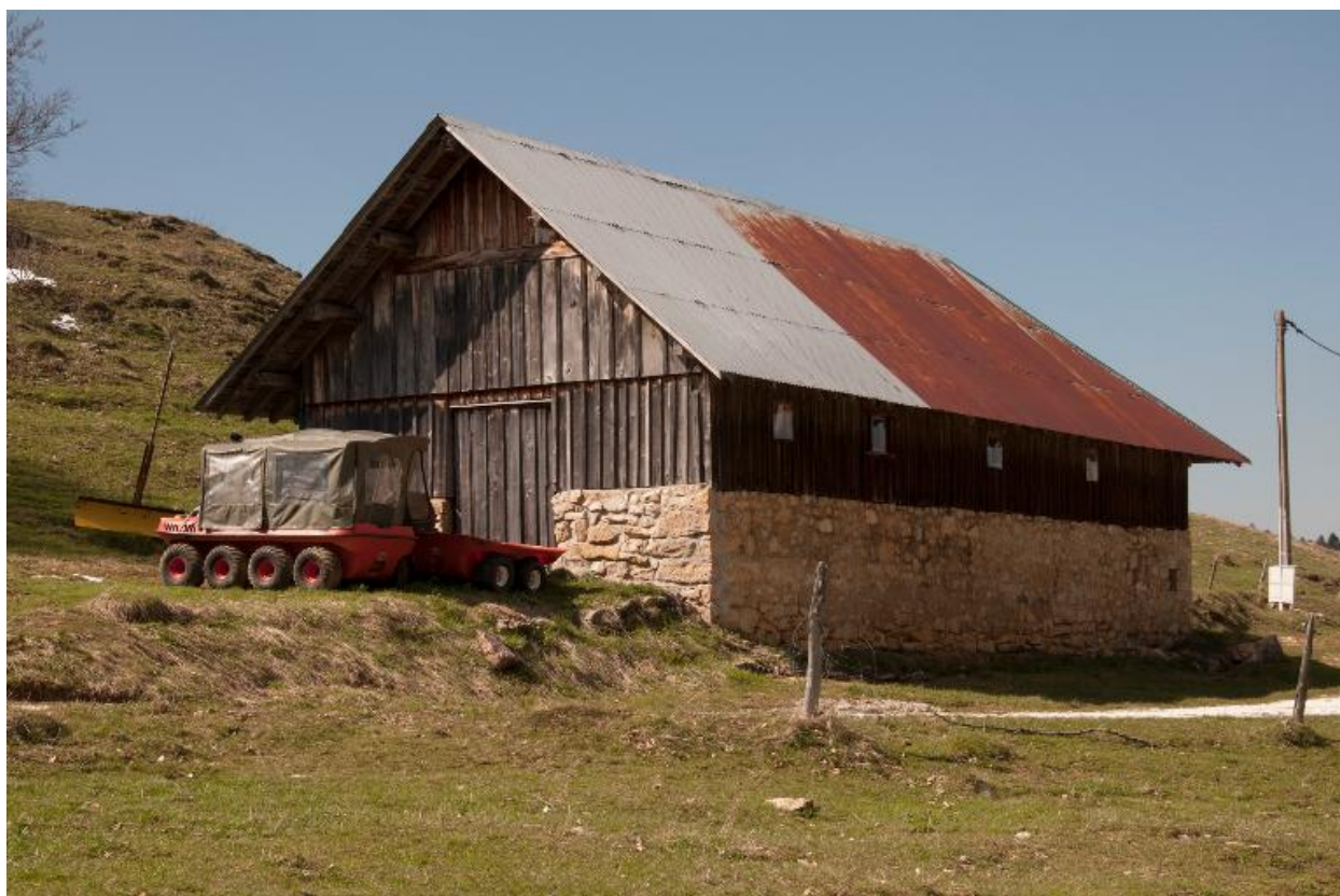
Vue de l'étable sud, depuis le sud-est.
