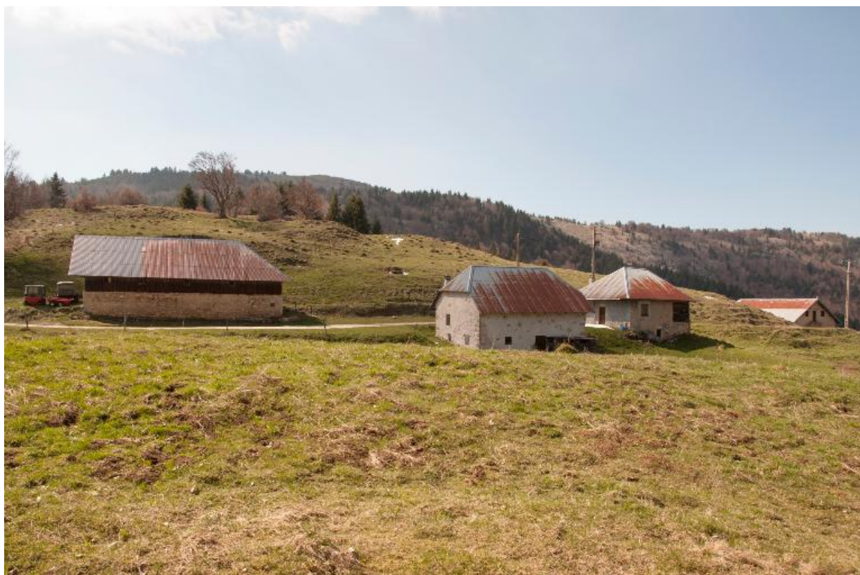
Vue générale depuis l'est.
