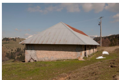
Vue de l'étable nord, depuis le sud-ouest. Phot. Denys Harreau IVR84_20167304776NUCA
