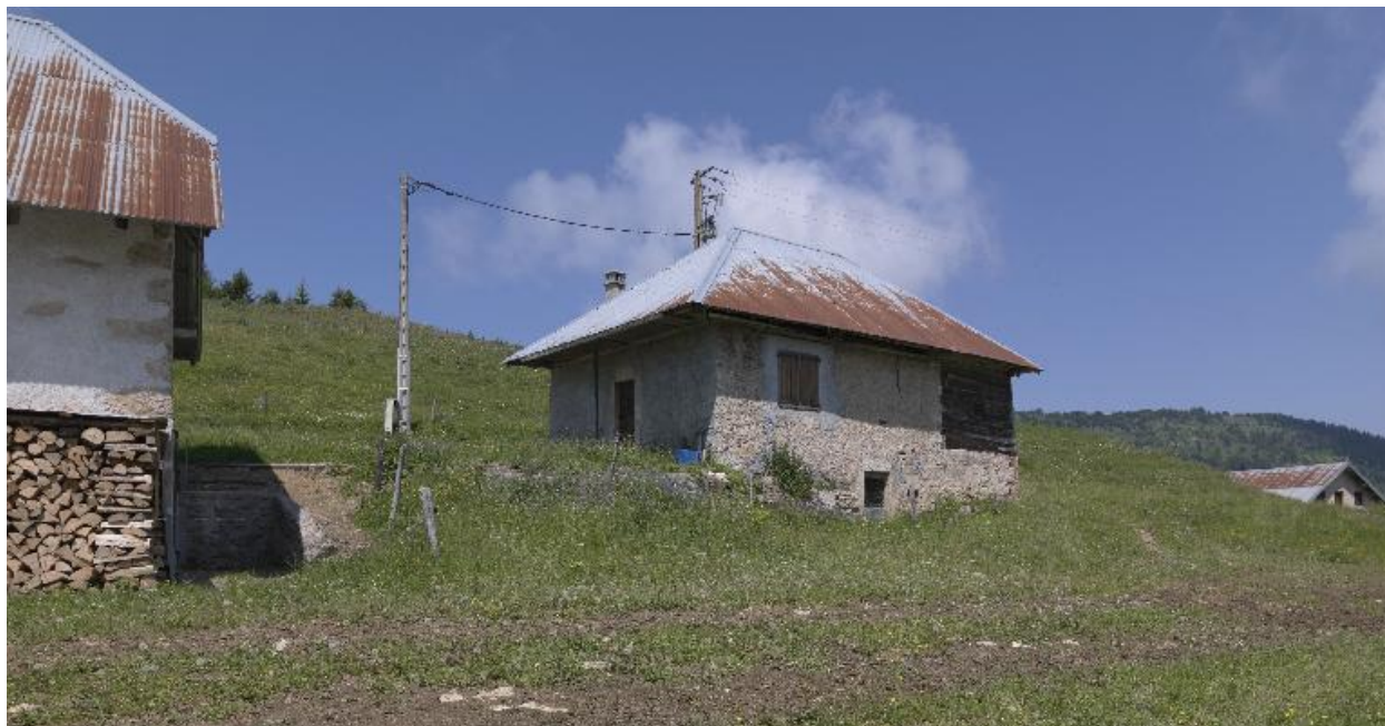
Vue du bâtiment nord, depuis le sud-est.
