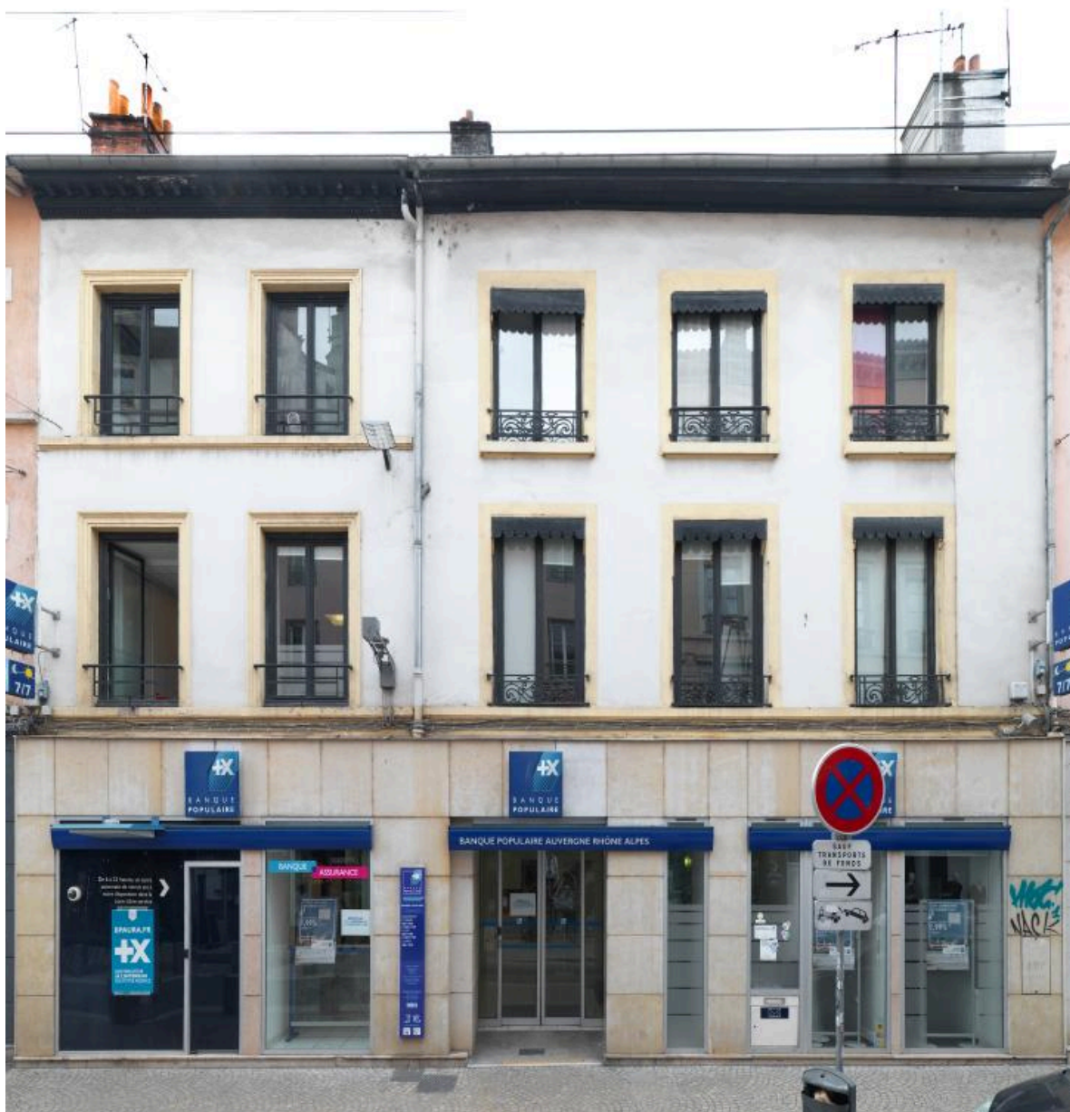
Vue d'ensemble des n°16 et 18 grande rue de Vaise, maisons jumelées
