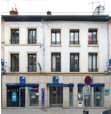
Vue d'ensemble des n°16 et 18 grande rue de Vaise, maisons jumelées Phot. Franck Trabouillet IVR84_20196900384NUCA
