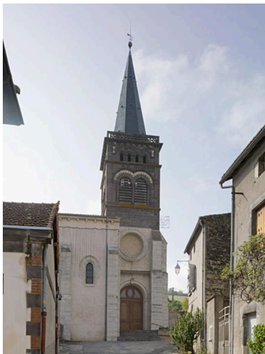
Vue partielle de la façade nord.
