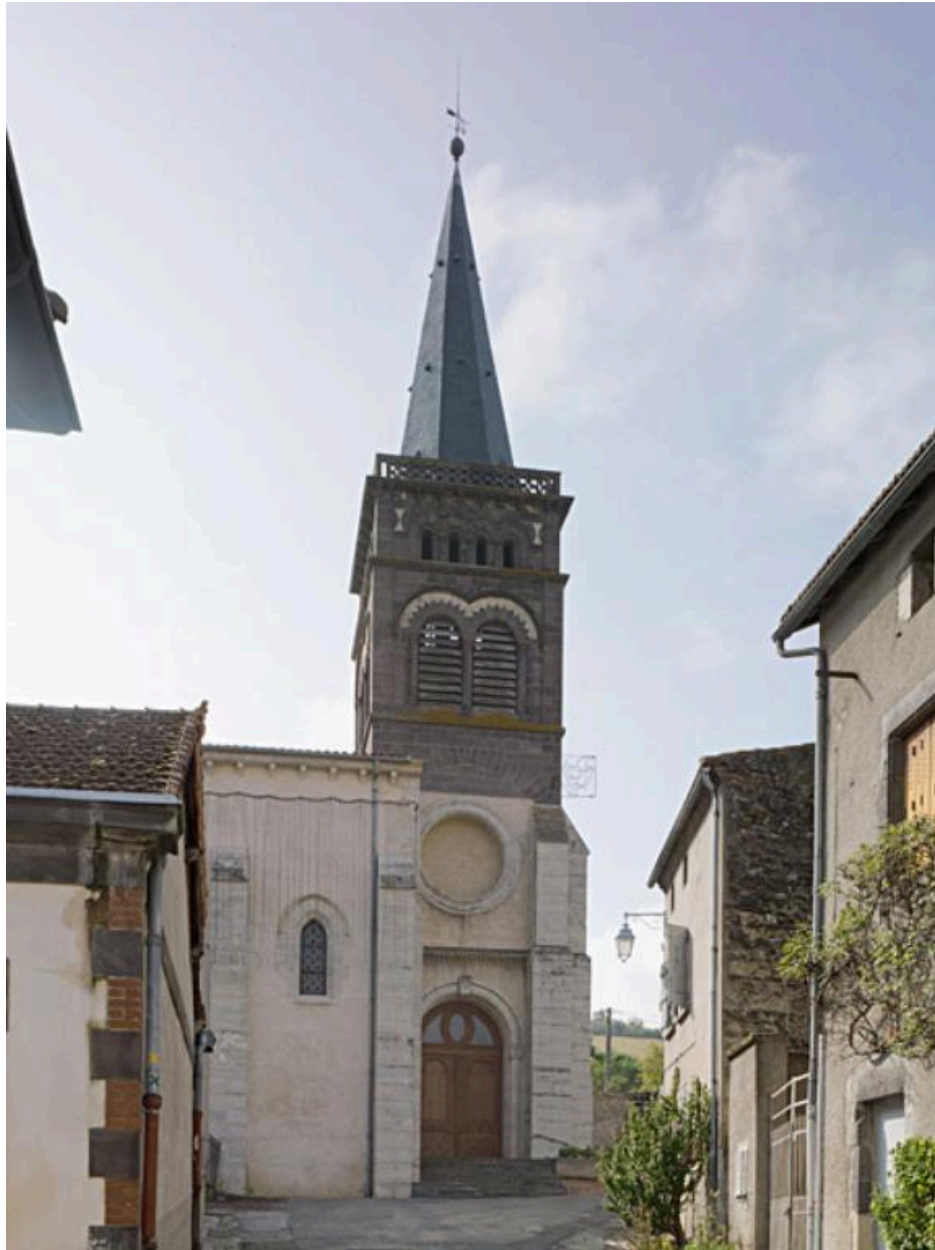
Vue partielle de la façade nord.
