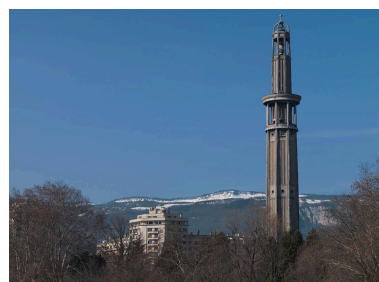
Tour Perret vue dans un paysage Phot. Thierry Leroy IVR84_20193800031NUCA
