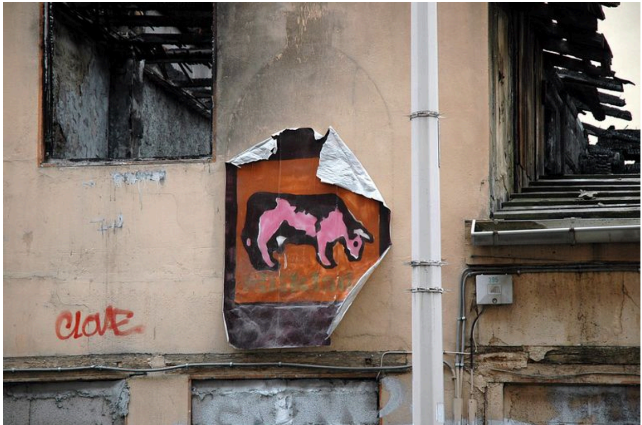
Détail de la façade
