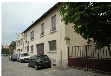
Vue ouest du site Phot. Nadine Halitim-Dubois IVR84_20246900714NUCA
