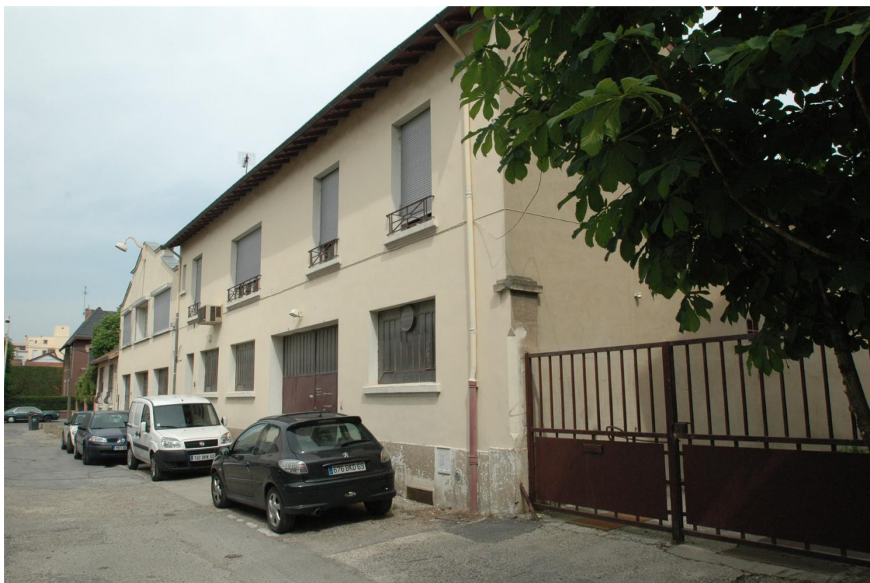
Vue ouest du site
