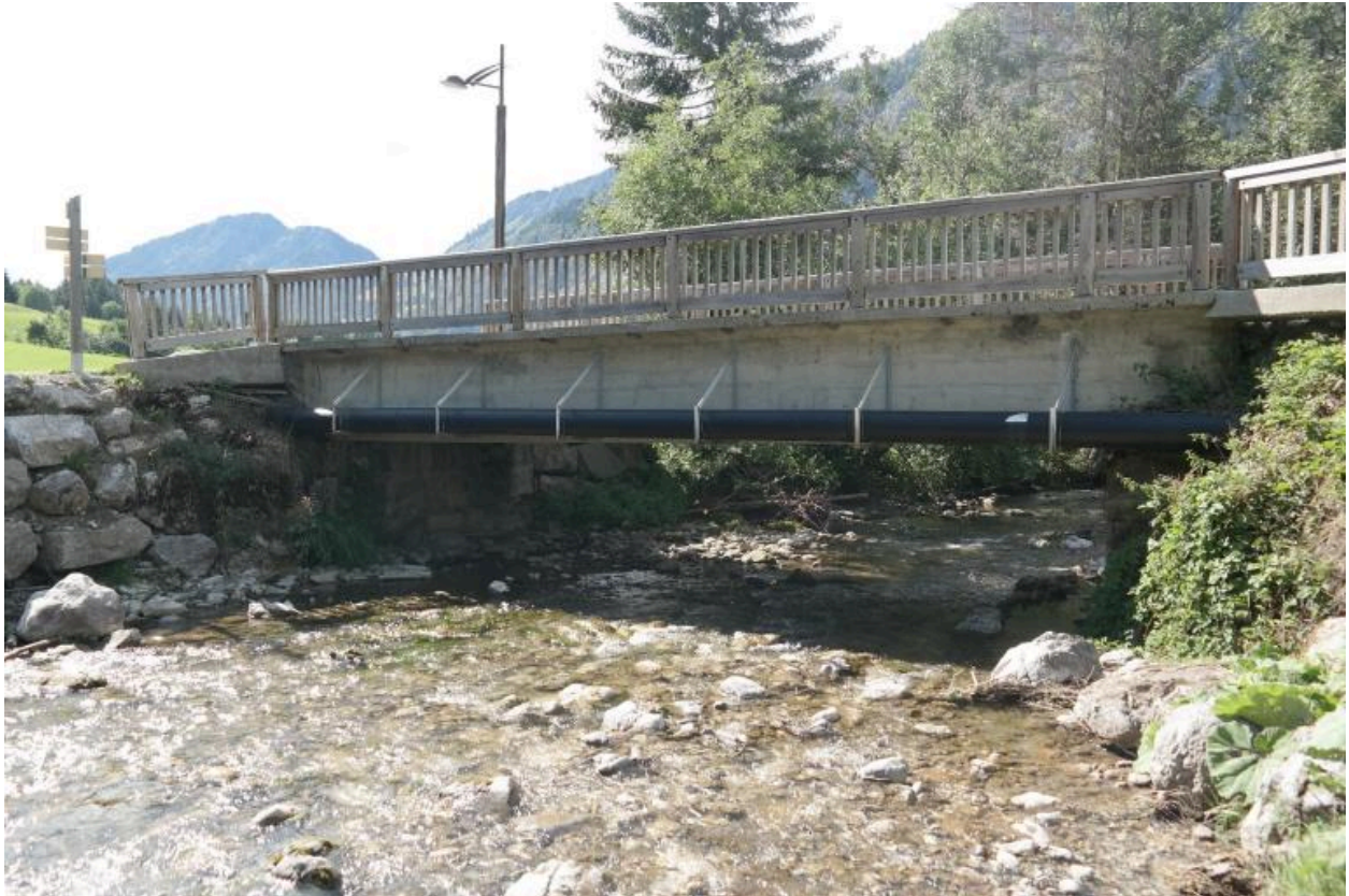
Pont de l'Ariot face amont
