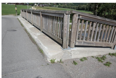
Pont de l'Ariot chaussée et rambarde Phot. Pascale Renard IVR84_20207400933NUCA
