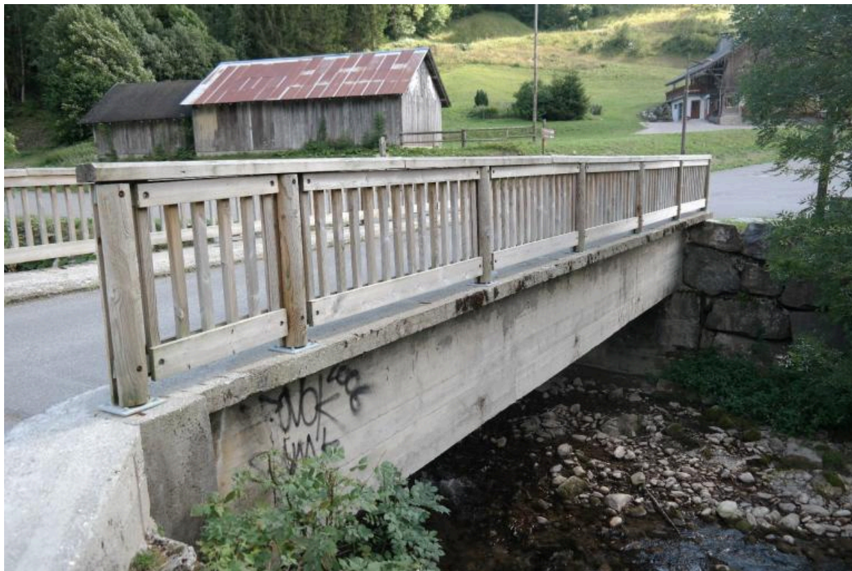
Pont de l'Ariot face aval
