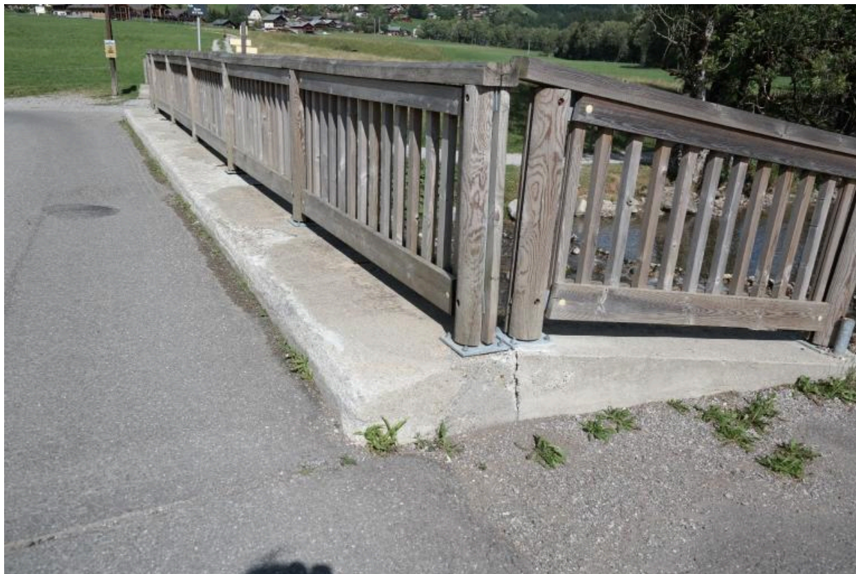
Pont de l'Ariot chaussée et rambarde
