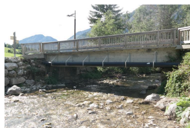
Pont de l'Ariot face amont Phot. Pascale Renard IVR84_20207400931NUCA
