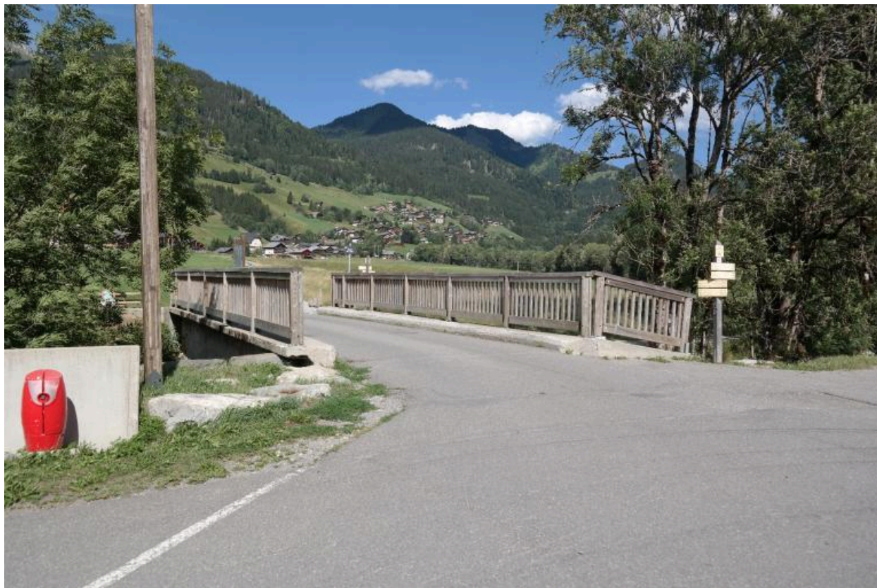
Vue générale du pont de l'Ariot
