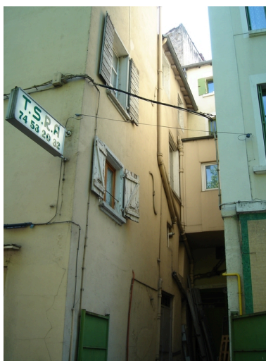
Façade latérale droite Phot. Isabelle Dupuis IVR82_20123800182NUCA
