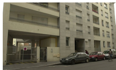
Rez-de-chaussée et entrée rue André-Philip Phot. Maryannick Chalabi IVR82_20086900665NUCA
