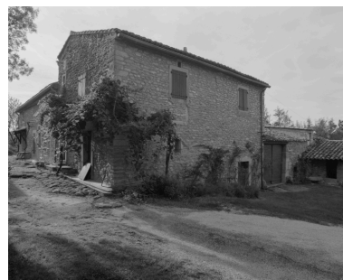
Vue générale de trois quarts : élévation latérale du corps principal et dépendances. Phot. Alain Franchella IVR82_19972600447X
