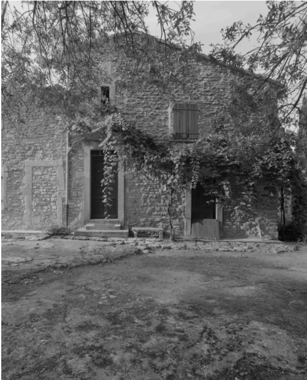
Vue partielle de l'élévation principale, côté droit : second logis accolé à l'ancien, dont la porte murée est gravée au linteau de la date 1771.
