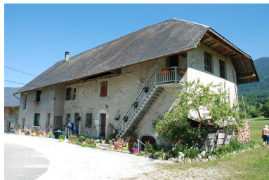
Vue d'ensemble. Phot. Caroline Guibaud IVR84_20167304582NUCA
