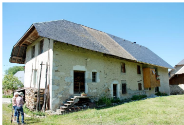
Vue arrière. Phot. Caroline Guibaud IVR84_20167304583NUCA
