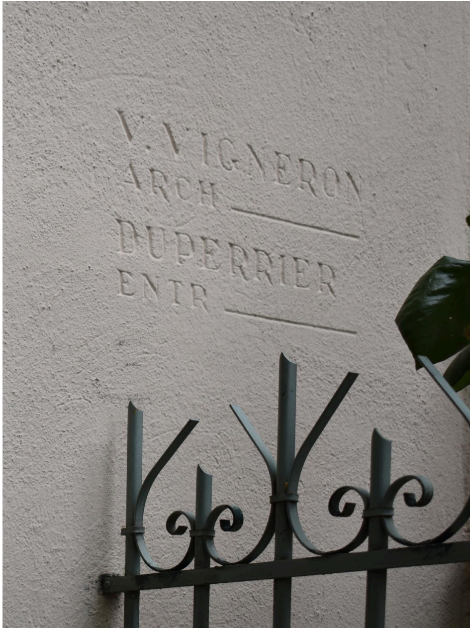
Signature de Valentin Vigneron, architecte et Duperrier, entrepreneur, façade
