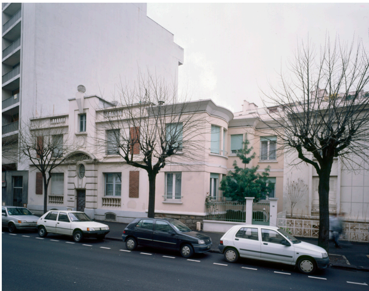
Façades sur le boulevard Cote-Blatin
