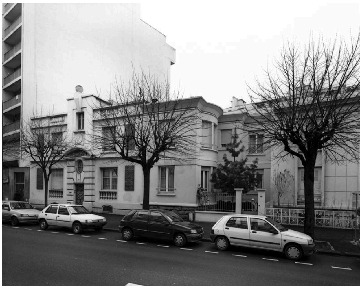
Façades sur le boulevard Cote-Blatin
