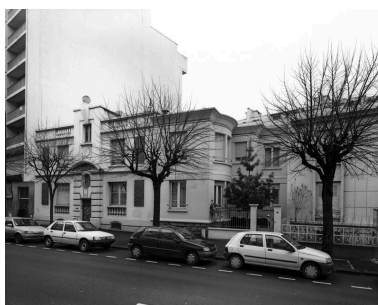
Façades sur le boulevard Cote-Blatin Phot. Roger Choplain, Phot. Roland Maston IVR83_20006300414V
