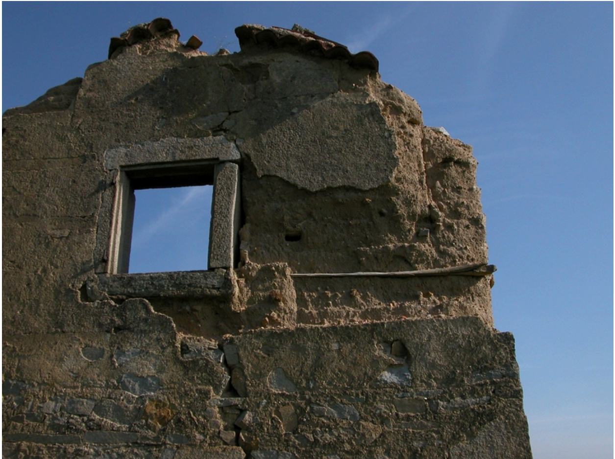
Détail de la fenêtre du 1er étage.
