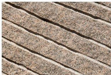
Détail du traitement de la surface du cube Phot. Franck Trabouillet IVR84_2021260009NUCA
