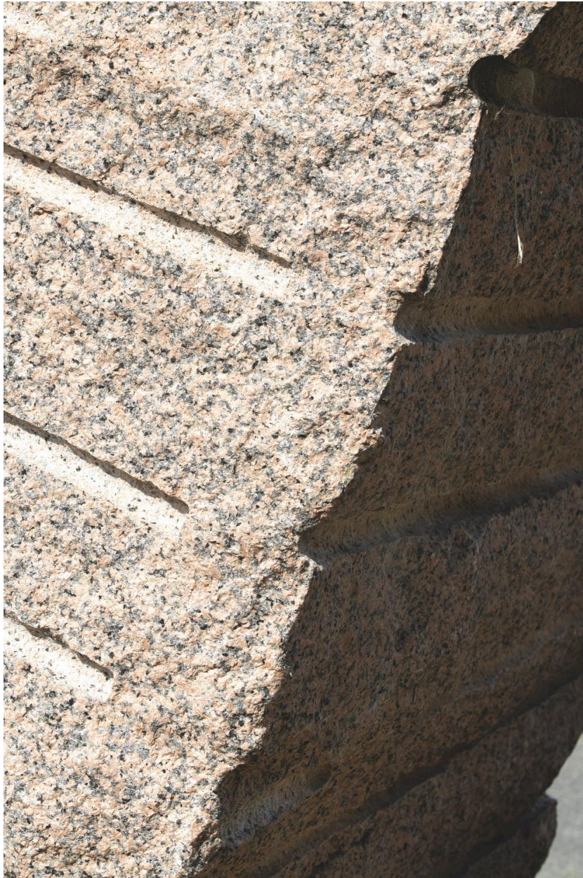
Epaufures dans un angle du cube
