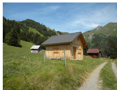
Vue d'un chalet récemment transformé au Chargieu Phot. Jérôme Daviet IVR84_20167304450NUCA
