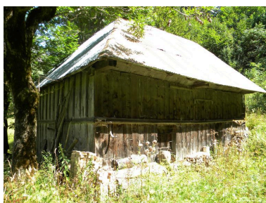
Vue de la façade d'une ancienne grange-étable aux Furets. Phot. Jérôme Daviet IVR84_20167304455NUCA
