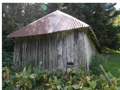
Vue du pignon d'une grange aux Furets Phot. Jérôme Daviet IVR84_20167304453NUCA
