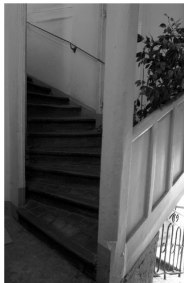
Petit escalier desservant l'étage de combles, au sommet du grand Phot. Bernard Ducouret IVR82_20036901483NUC
