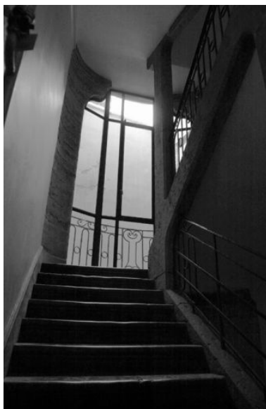
Escalier, vue vers un repos Phot. Bernard Ducouret IVR82_20036901482NUC
