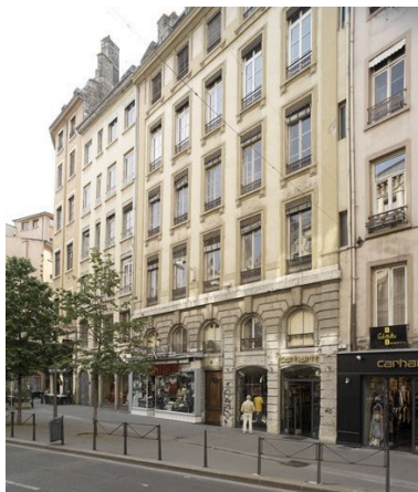
Vue générale de la façade depuis le sol Phot. Didier Gourbin IVR82_20056901460NUCA
