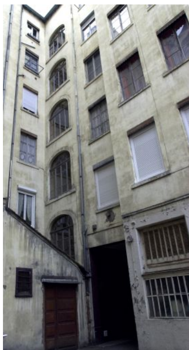
Vue de la travée d'escalier du 9 cours Charlemagne depuis l'angle sud-est de la cour Phot. Chantal Archer-Galéa IVR82_20016901246NUCA
