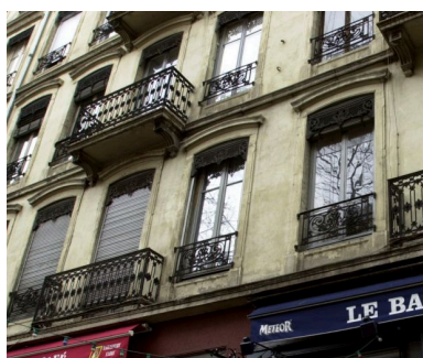
Détail des fenêtres, 25 cours Suchet Phot. Chantal Archer-Galéa IVR82_20016901242NUCA
