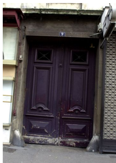
Porte d'entrée, 9 cours Charlemagne Phot. Chantal Archer-Galéa IVR82_20016901254NUCA
