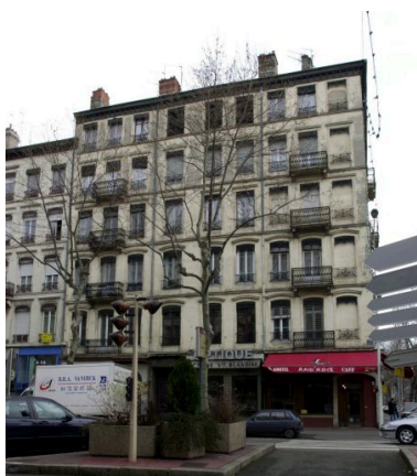
Elévation, 9 cours Charlemagne Phot. Chantal Archer-Galéa IVR82_20016901252NUCA
