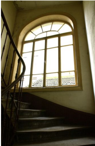
Détail de la fenêtre de la cage d'escalier, 9 cours Charlemagne Phot. Chantal Archer-Galéa IVR82_20016901248NUCA
