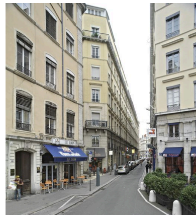
Elévation antérieure et pan coupé depuis le quai des Célestins Phot. Eric Dessert IVR82_20076902486NUCA
