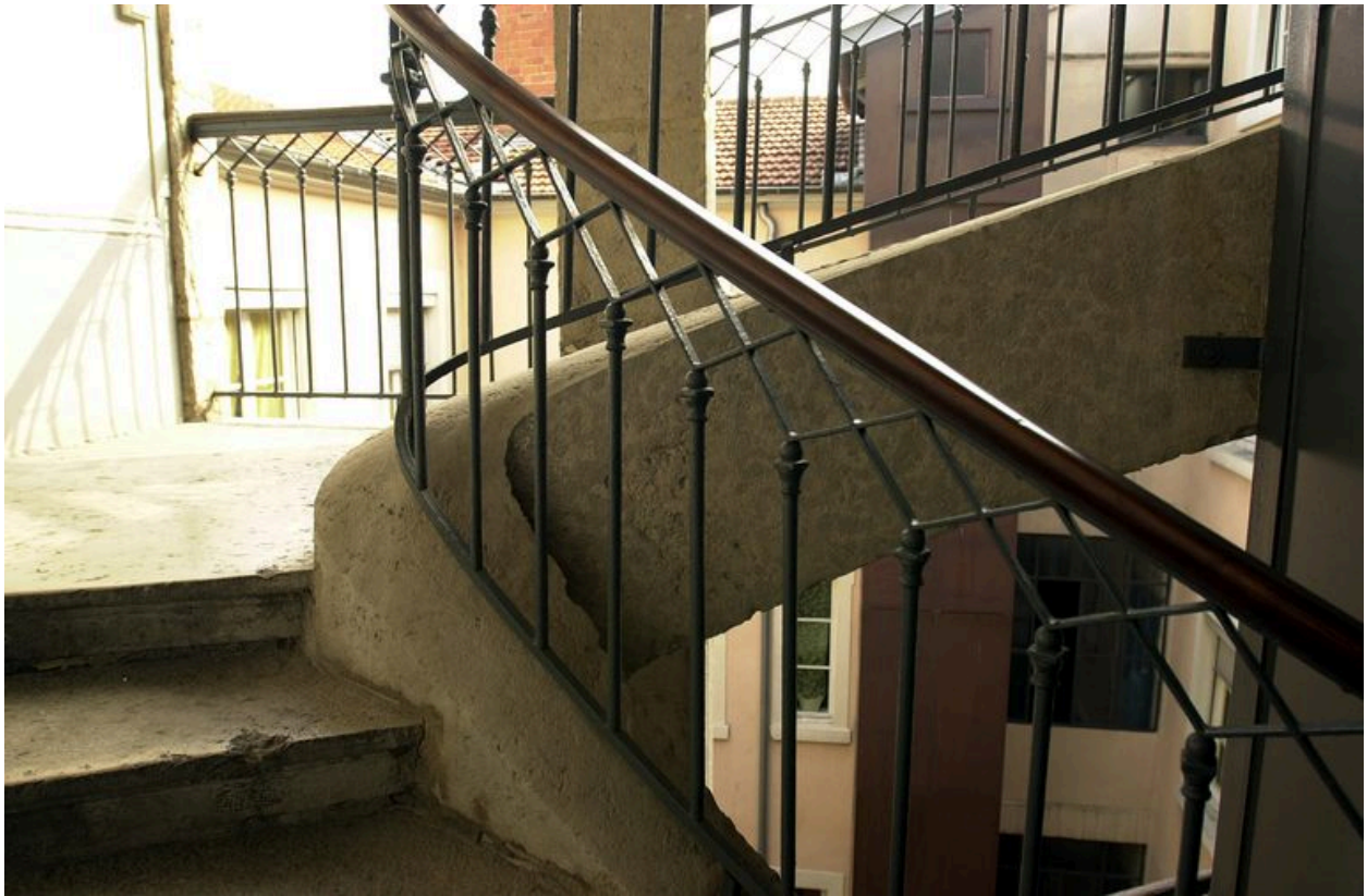
Cage d'escalier ouest : détail du limon et du garde-corps
