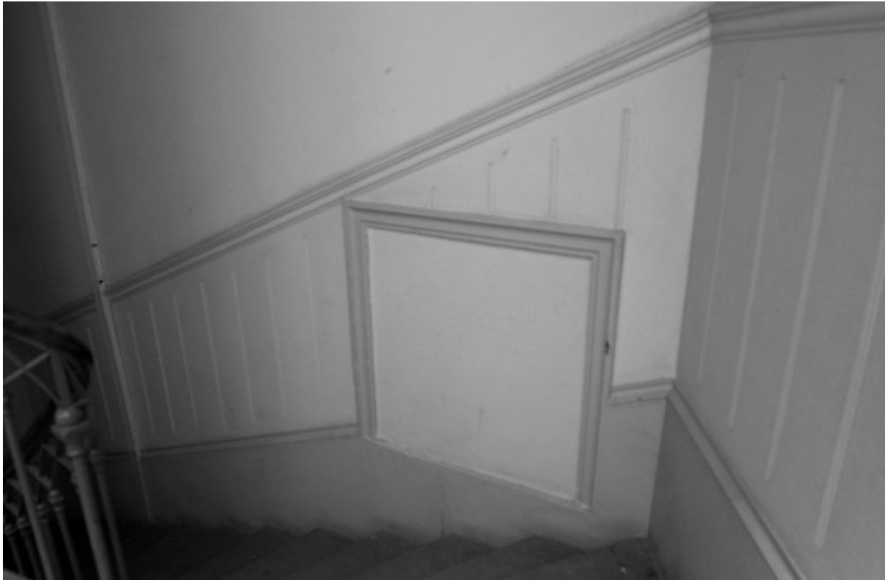
Cage d'escalier ouest : fenêtre de second jour condamnée
