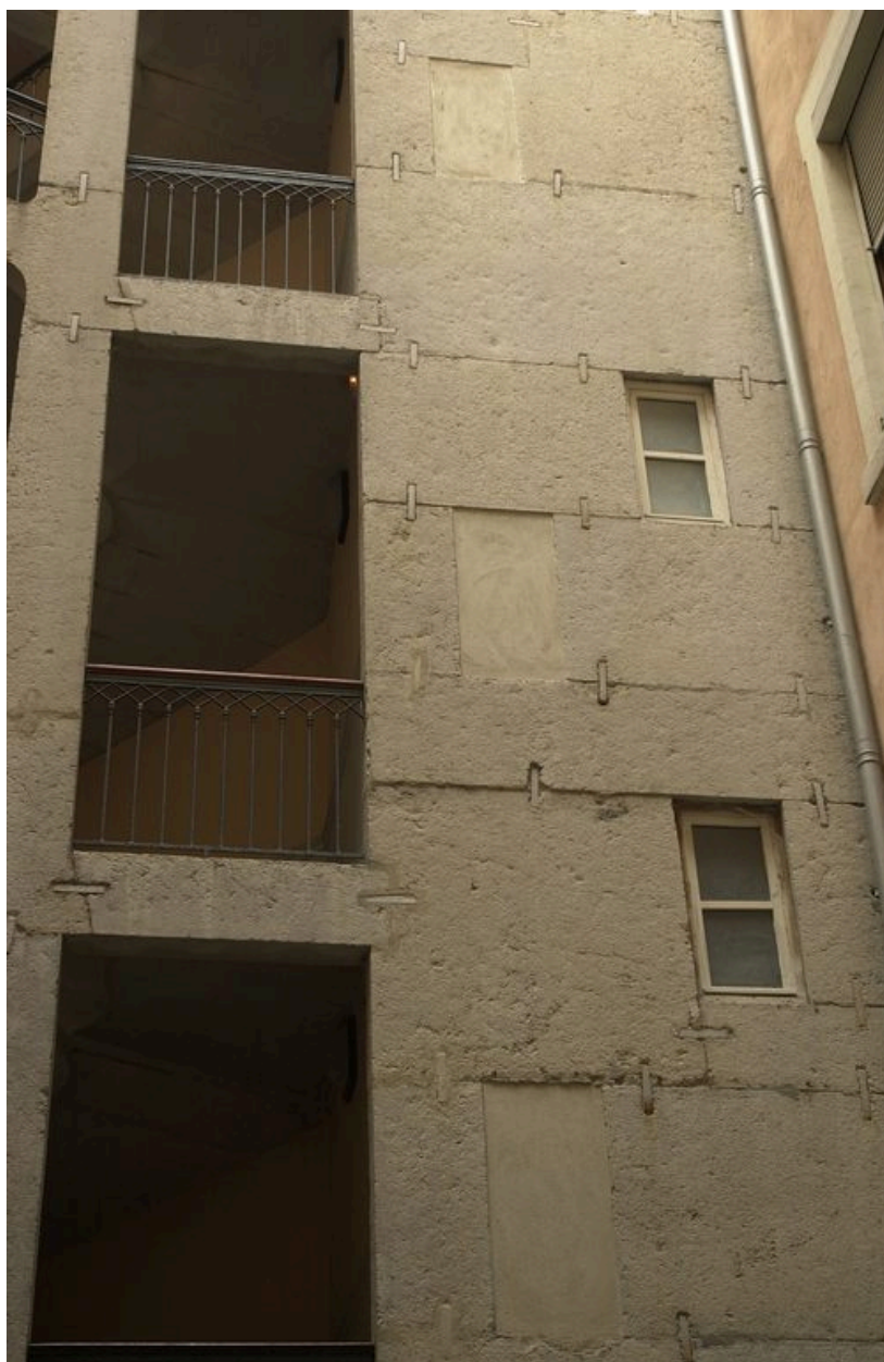
Cage d'escalier ouest : agrafes métalliques
