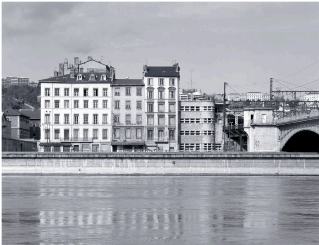
Vue générale depuis l'est
