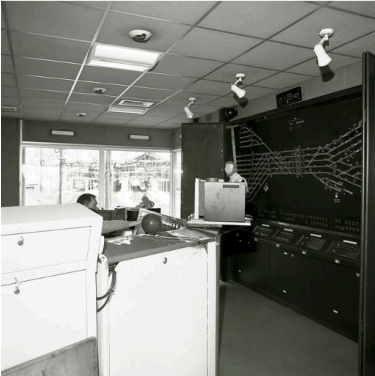
Vue de la salle de commande
