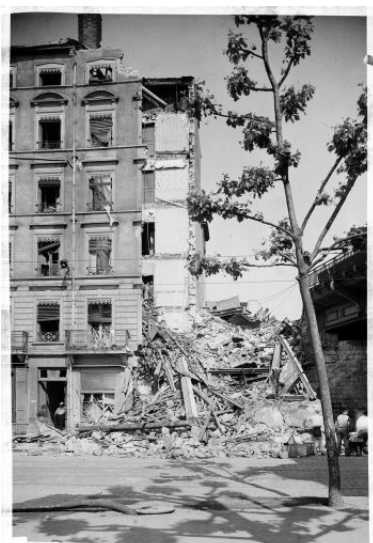
Vue du quai après les bombardements du 26 mai 1944. Photogr. IVR82_20026903085NUCB
