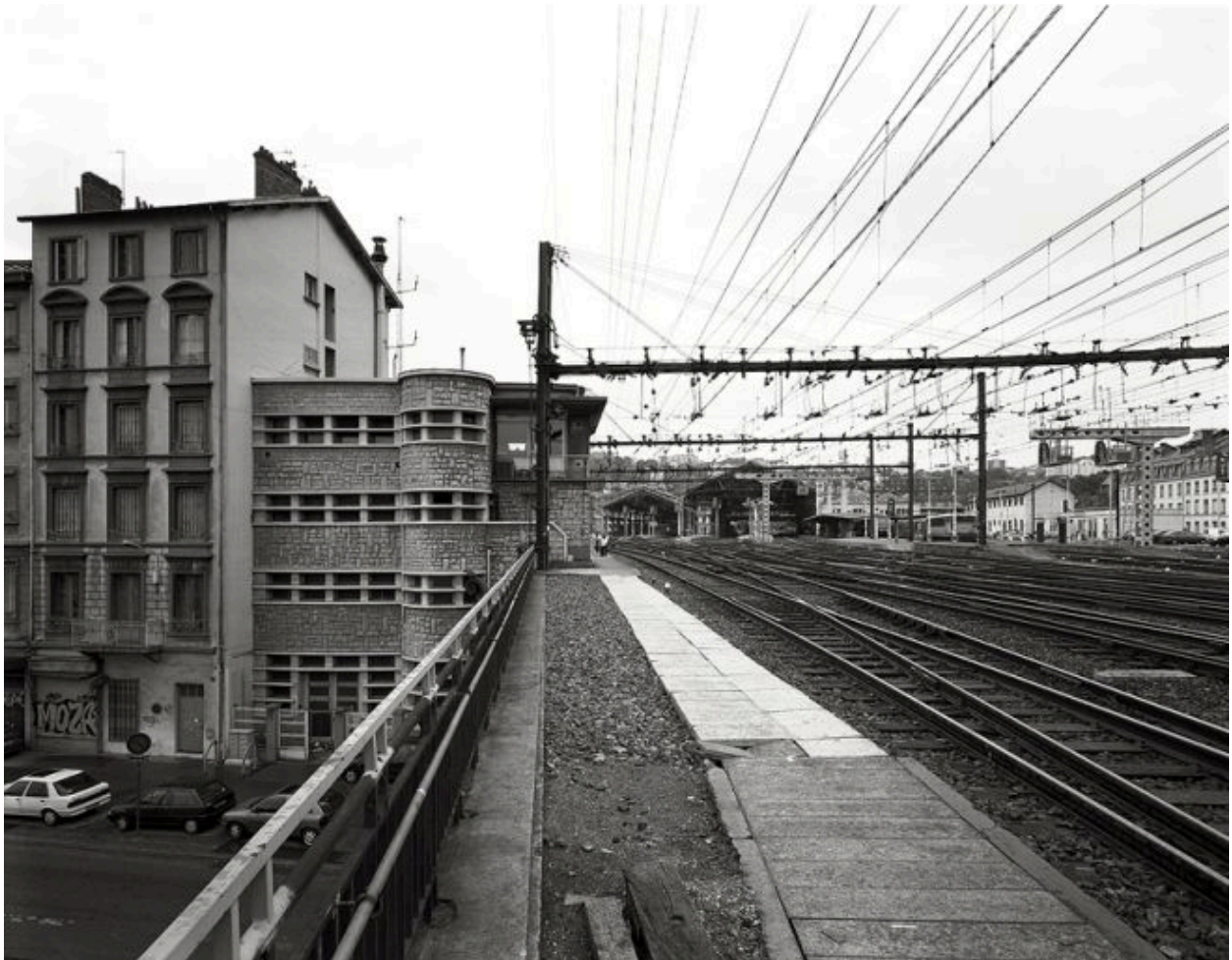
Vue générale depuis l'est
