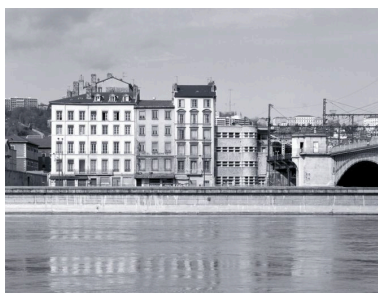
Vue générale depuis l'est Phot. Eric Dessert IVR82_20026903020X
