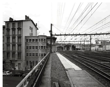
Vue générale depuis l'est Phot. Eric Dessert IVR82_20026903534V
