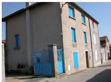
Vue générale (élévations sur le chemin de la Sablière) depuis le nord-est. Phot. Thierry Monnet IVR82_20134200959NUCA
