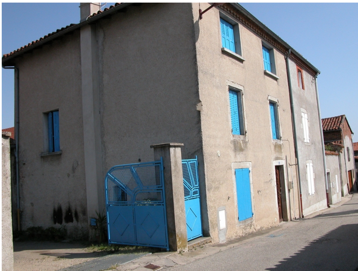
Vue générale (élévations sur le chemin de la Sablière) depuis le nord-est.
