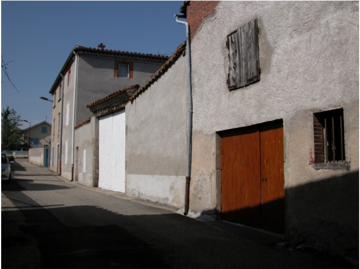
Vue d'ensemble (élévations sur le chemin de la Sablière) depuis le sud-est.
