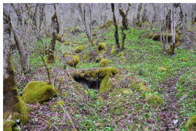
Canal de dérivation avec un petit ouvrage de franchissement. Phot. Clara Bérelle IVR84_20197300380NUCA
