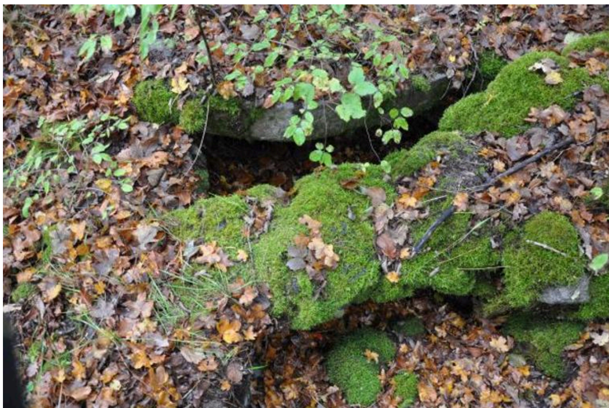
Canal de dérivation en partie souterrain et en partie à ciel ouvert.
