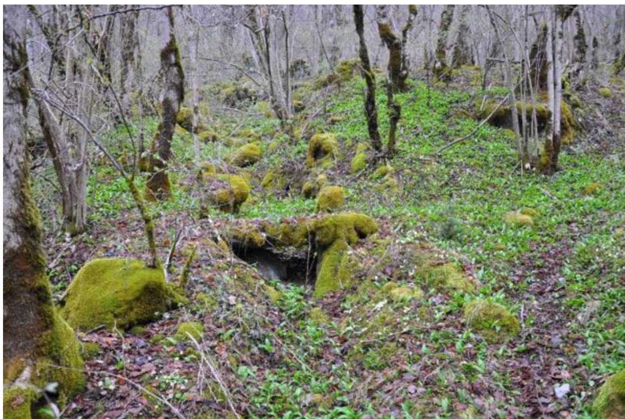
Canal de dérivation avec un petit ouvrage de franchissement.
