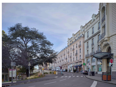
Début du boulevard Vaquez, depuis l'avenue Védérine Phot. Christian Parisey, Phot. Marion Urbanek IVR84_20236301083NUC4A
