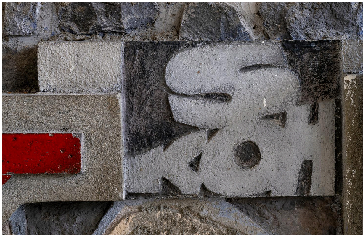
Panneau n°1 : détail d'un élément de la partie supérieure (lettres SHOK)
